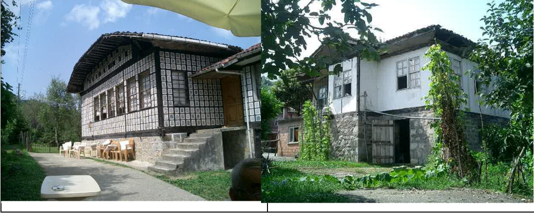
Şekil 44. Geleneksel mimari örneği( Rize/ Fındıklı - Çağlayan Köyü)
