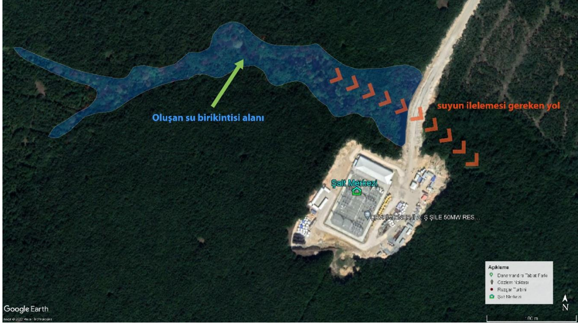
Şekil 32. Şalt merkezinde oluşan su birikintisinin konumu
