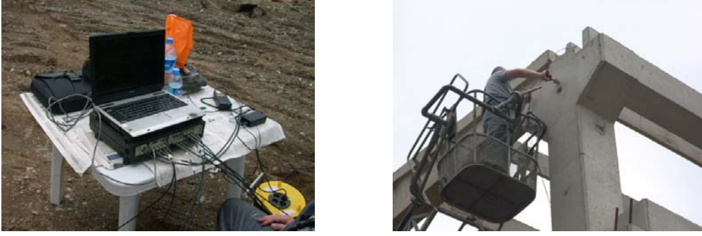
Şekil 2.17. Üretim tesisi üzerinde gerçekleştirilen deneysel ölçümlere ait görüntüler
