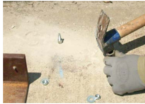
b. Dübel ve çelik vida montajı
