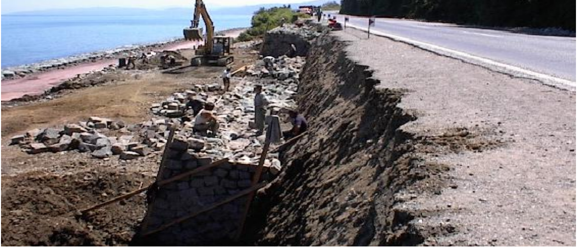
Şekil 24. Karadeniz Sahil Yolu Dolgu ve Tahkimat Çalışmaları
