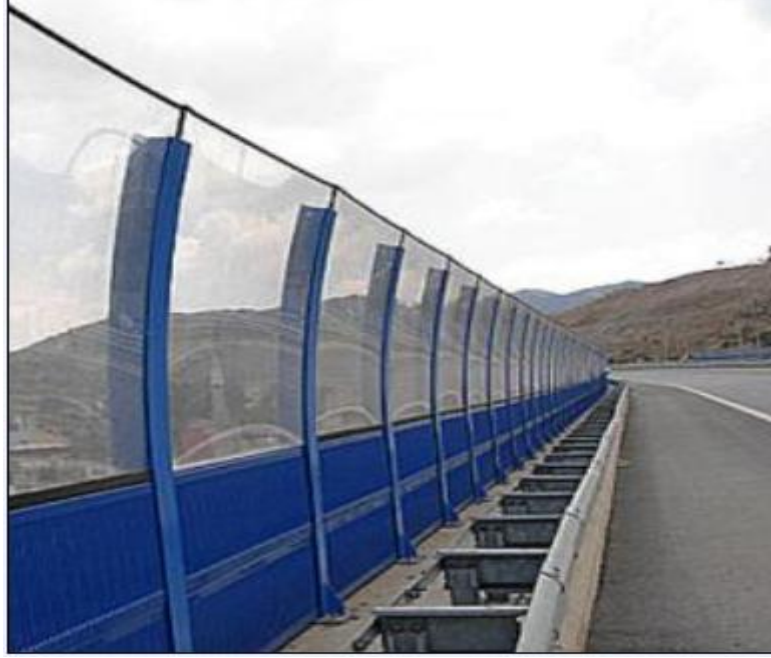
Şekil 9. Gürültü perdesi uygulaması
