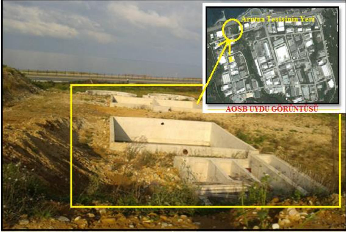
Şekil 2.1. AOSBAAT'nin inşaat sahasından bir görüntü
