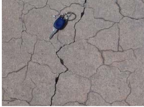
Şekil 19. İzmir Adnan Menderes Havalimanı değiştirilen pist ve taksi yolu betonu (Mayıs, 2004).
