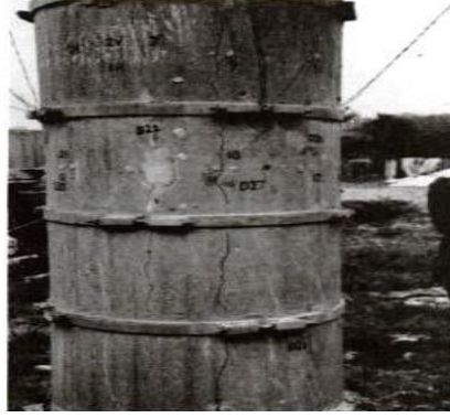
Şekil 15. Mott MacDonald test sahasında bir karayolu köprüsünün kolonu, Devon (Swamy, 1992)
