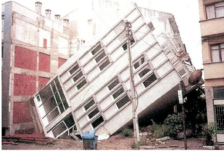
Şekil 30. Adapazarı'nda sıvılaşma kaynaklı taşıma gücü kaybı ve farklı oturma kaynaklı devrilme (Yasuda, 2004).
