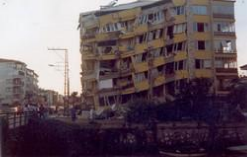
Şekil 16. 17 ağustos depreminde burulma nedeni ile ağır hasar görmüş bir yapı.
