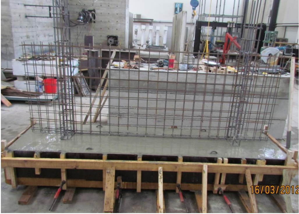
Şekil 54. Deney elemanı temel sistemi betonunun dökümü.
