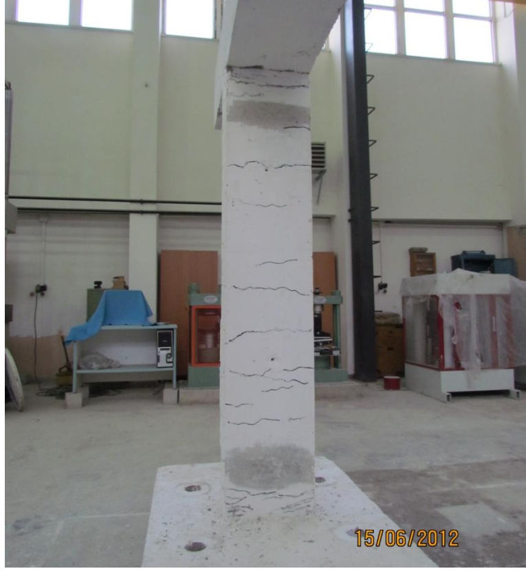
Şekil 89. Kolon boyunca çatlak yayılımı.
