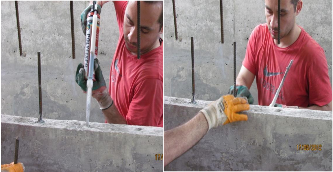
Şekil 58. Ankraj çubuklarının yerleştirilmesi.
