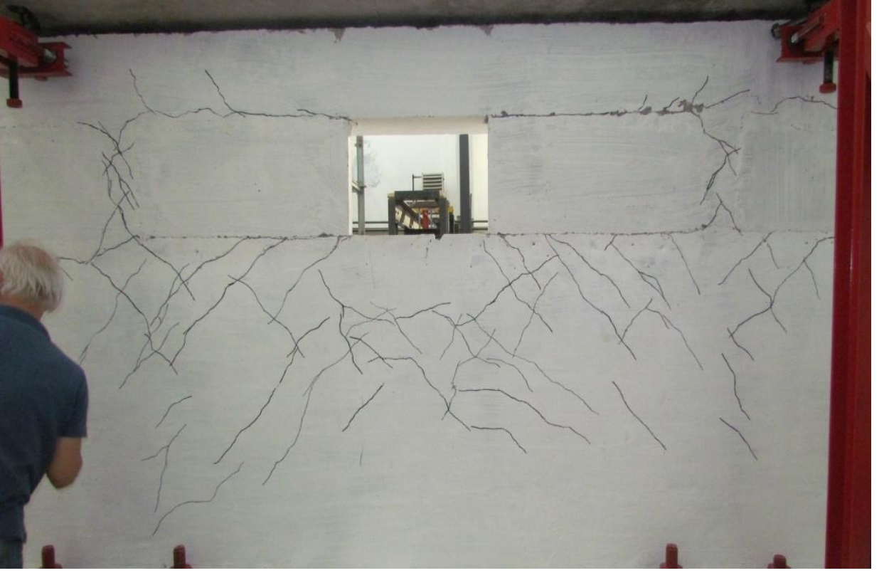
Şekil 115. Kolon kiriş ve perdede yoğunlaşan çatlaklar.
