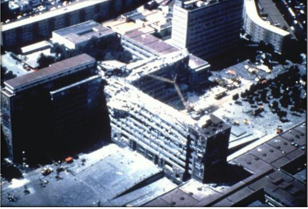
Şekil 20. Deprem derzi olmayan bir yapıda A3 düzensizliği nedeni ile oluşan hasarlar [16].
