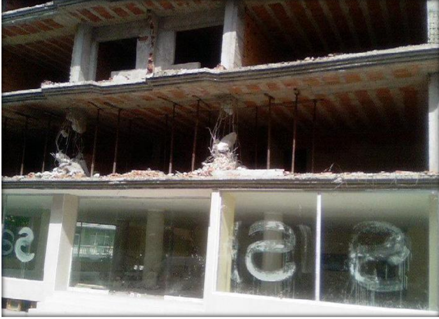
Şekil 26. Kullanım alanı açmak için kesilen kolonlar.
