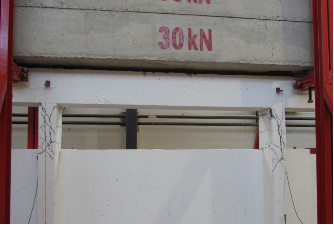
Şekil 96. Yükleme boyunca kolonlarda oluşan diyagonal çatlaklar.
