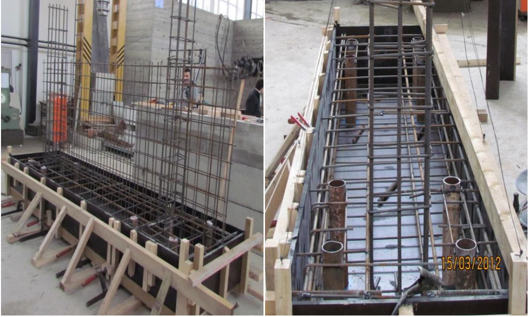
Şekil 53. Deney elemanlarının temel sistemi, kolon- perde duvar donatıları ve ankraj delikleri.
