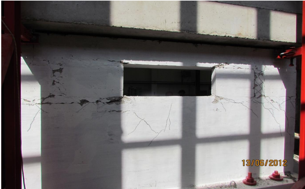
Şekil 104. 240 kN yük seviyesinde kolonun perdeyle birleşen yüzünde yoğunlaşan kesme çatlakları ile kiriş, perde ve kanat duvarda meydana gelen hasarlar.
