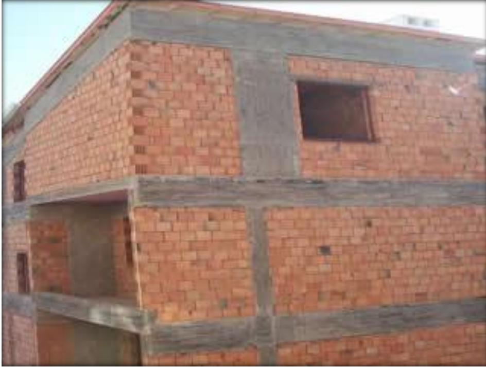
Şekil 25. Alt kattaki kolonun üzerine oturmuş bir perde [17].
