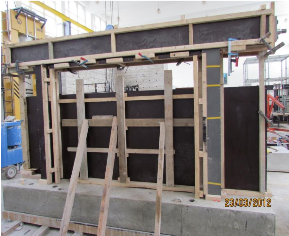
Şekil 55. Kolon, kiriş ve perde duvar kalıplarının yapılması.
