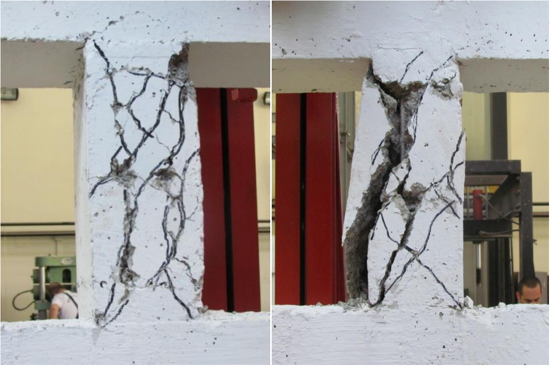
Şekil 97. Kolonlarda oluşan nihai hasarlar.
