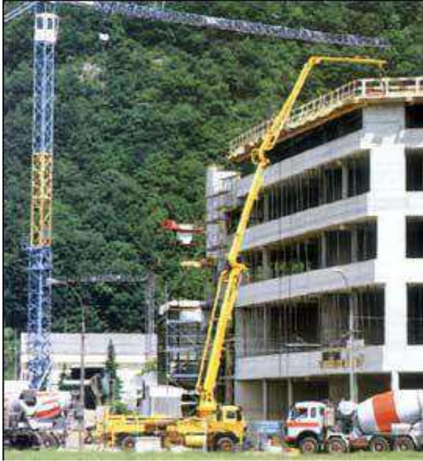
Şekil 27. Üst katlara çıktıkça artan kolon boyutları [17].
