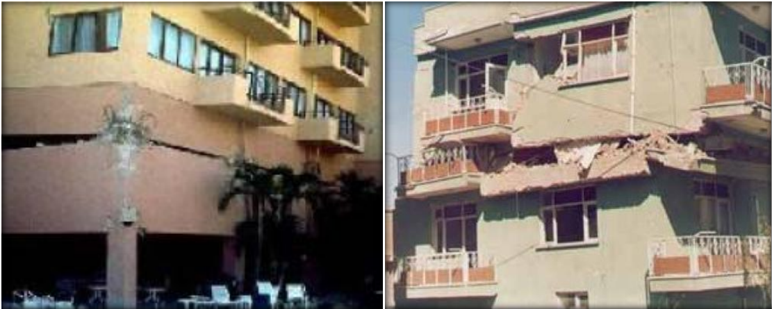
Şekil 21. Çerçeve sistemlerde dolgu duvar süreksizliklerinden ötürü meydana gelen zayıf kat oluşumu [17].
