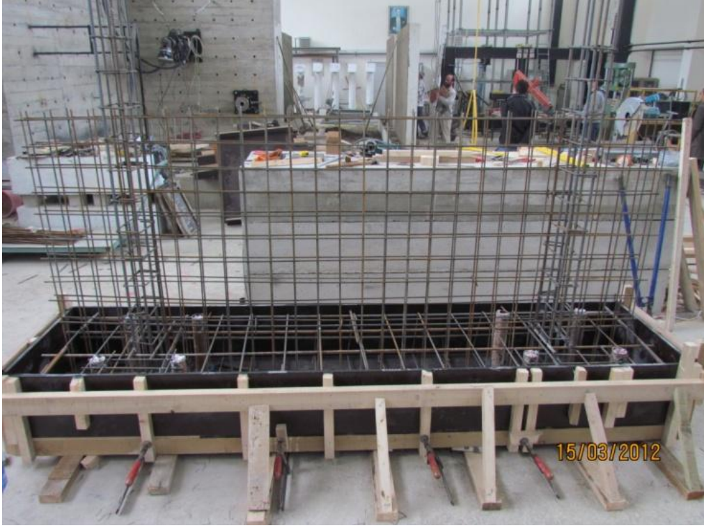
Şekil 40. Temel sisteminden bir görünüm.
