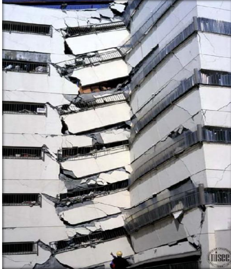
Şekil 19. L tipi plana sahip bir yapıda A3 düzensizliği nedeni ile oluşan hasarlar.
