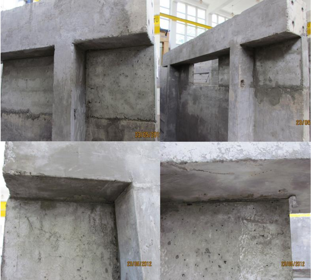
Şekil 61. Kanat duvar ilave edilmiş bazı deney elemanları.
