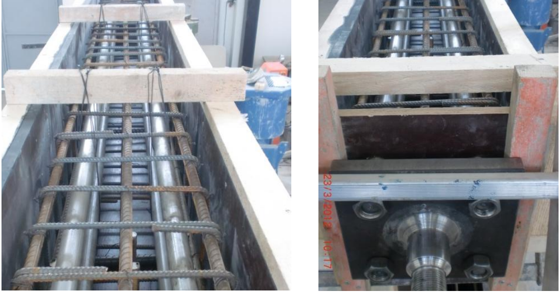
Şekil 56. Kiriş donatıları ve kiriş içinde bırakılan kanalların görünüşleri.
