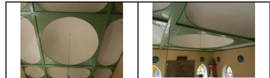
Şekil 3. Düzköy Merkez Camisi gizli kubbe ve beşik tonozumsu üstörtüsü.
