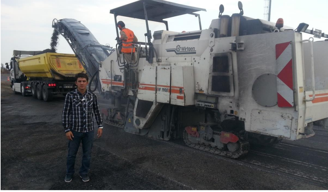
Şekil 2.1. Asfalt kazıma makinesi (freze) ile kaplamanın kazınması
