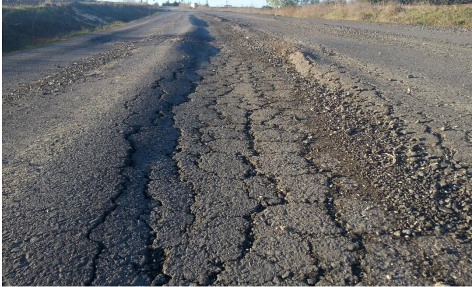
Şekil 1.13. Yerel oturmalar
