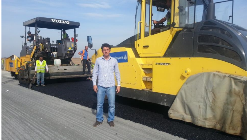
Şekil 3.18. Fabrikada üretilen karışımın yola serilmesi
