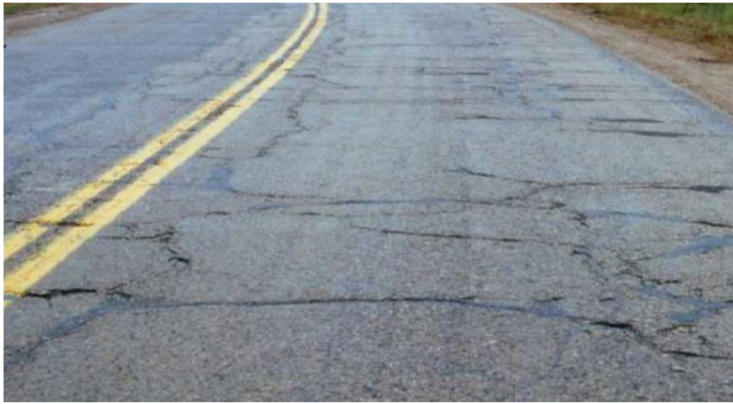
Şekil 1.11. Blok çatlaklar.[17]
