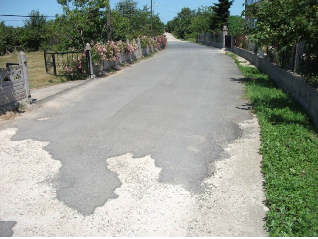
Şekil 1.11. Trabzon Beşikdüzü İlçesi Aksaklı Köyü mahalle içi yolu.
