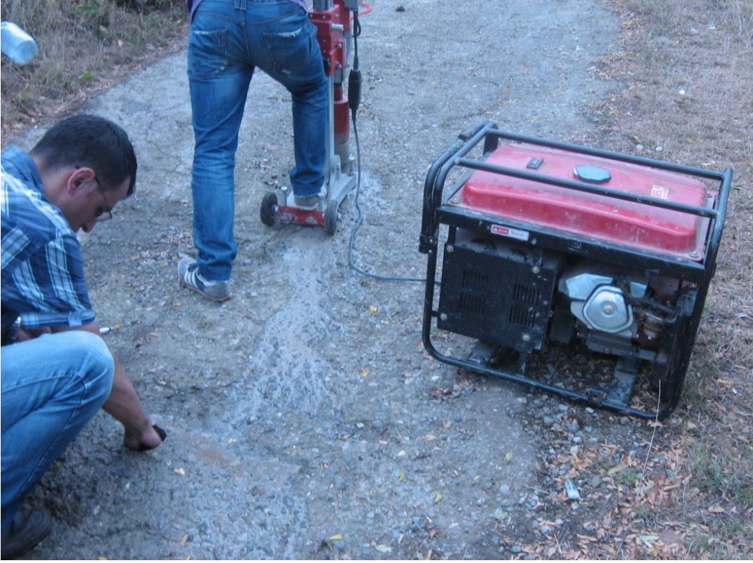
Şekil 2.3. Bulak Köyü Soğuksu mevki, karot numune alımı.
