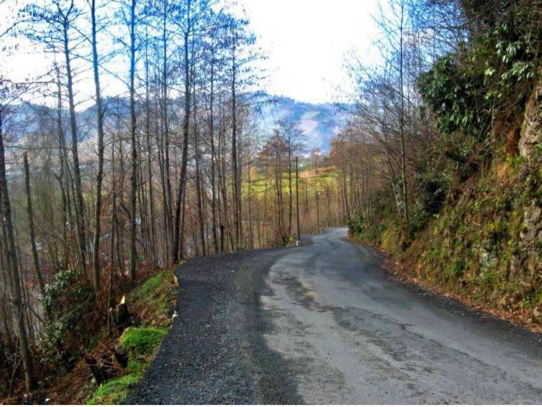
Şekil 1.18. Rize İyidere Denizgören Köyü, eski bozulmuş rijit kaplama üzerine esnek kaplama. (Rijit kaplama 1995 yılında yapılmıştır)
