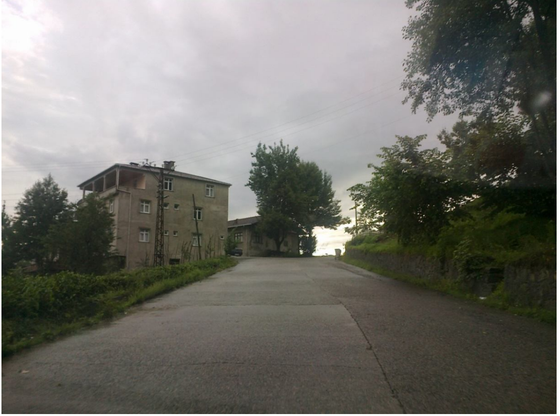
Şekil 1.16.Trabzon Of Uğurlu Beldesi, yaklaşık 20 senedir hizmet veren rijit kaplama üzerine 2013 yılında konfor arttırması için 5 cm binder tabakası serilmiştir.
