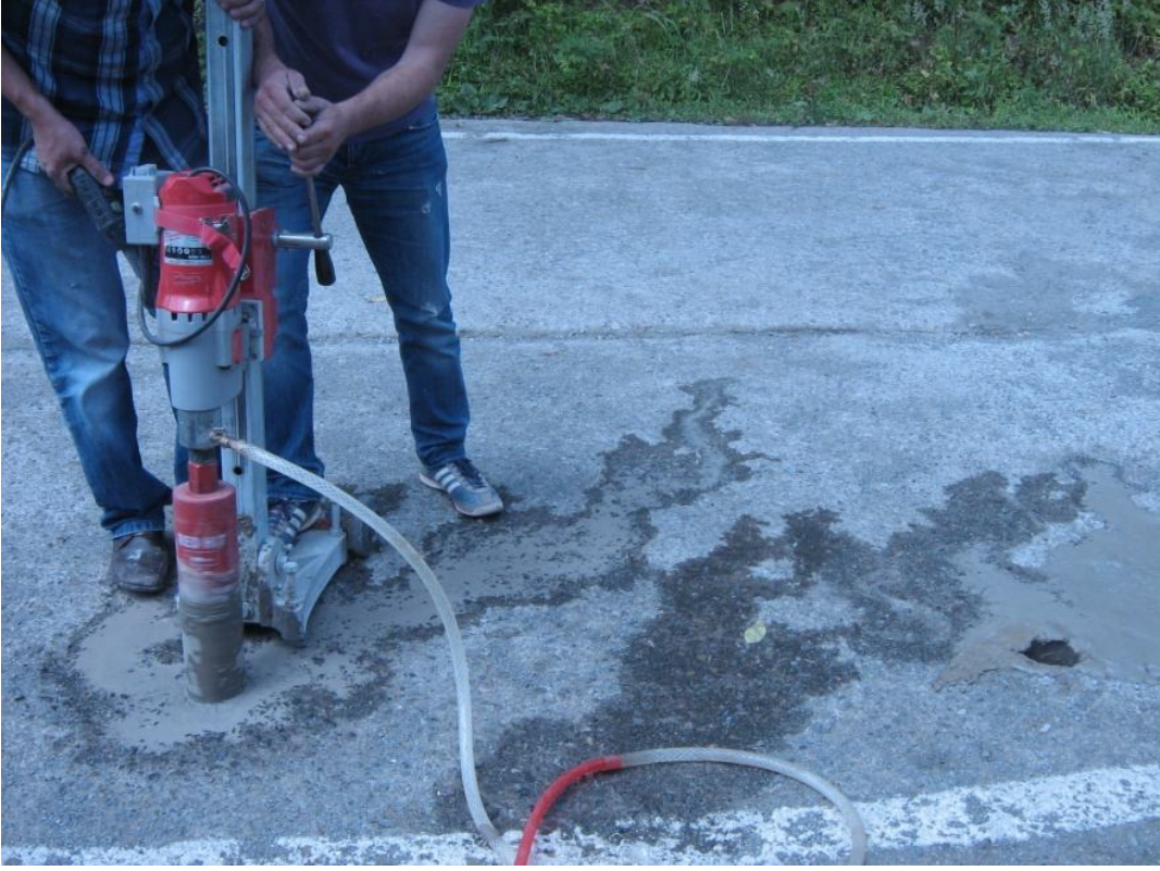
Şekil 2.5. Yeşilyurt Çatak ve Dolaylı mevkisinden beton yoldan karot numune alımı.
