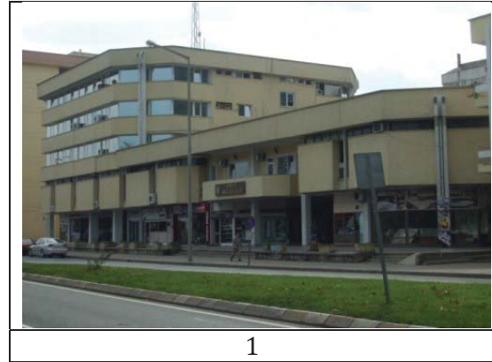
Şekil 4. Ordu ili Uluslararası stil yapı örneği
