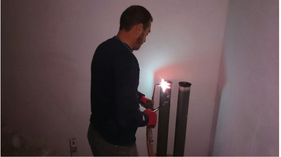
Şekil 53. Anket yapılan bir inşaat şantiyesinde, kalorifer borusuna kaynak yapan bir işçinin kaynak gözlüğü kullanmadığı görülmektedir.
