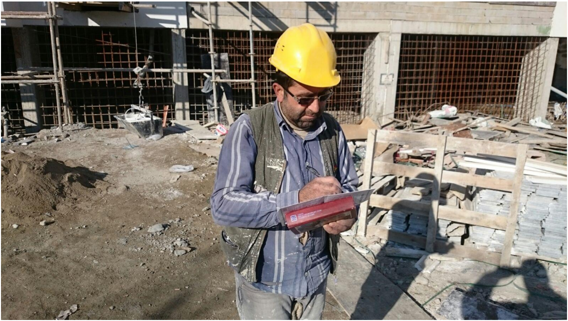
Şekil 47. Anket yapılan bir inşaat şantiyesinde, işçinin baretini taktığı görülmektedir
