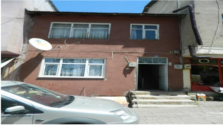
Şekil 29. Çarpışma etkisindeki yığma bina
