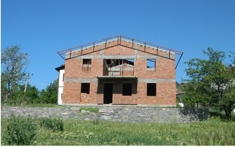
Şekil 24. Duvar boşluk oranı orta olan yığma bina
