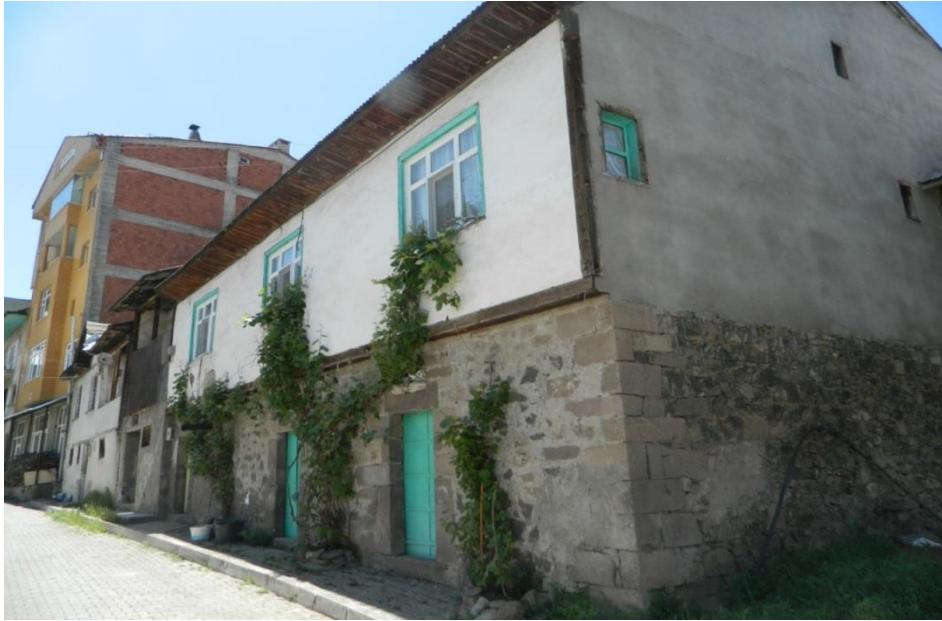
Şekil 25. Duvar boşluk oranı az olan yığma bina
