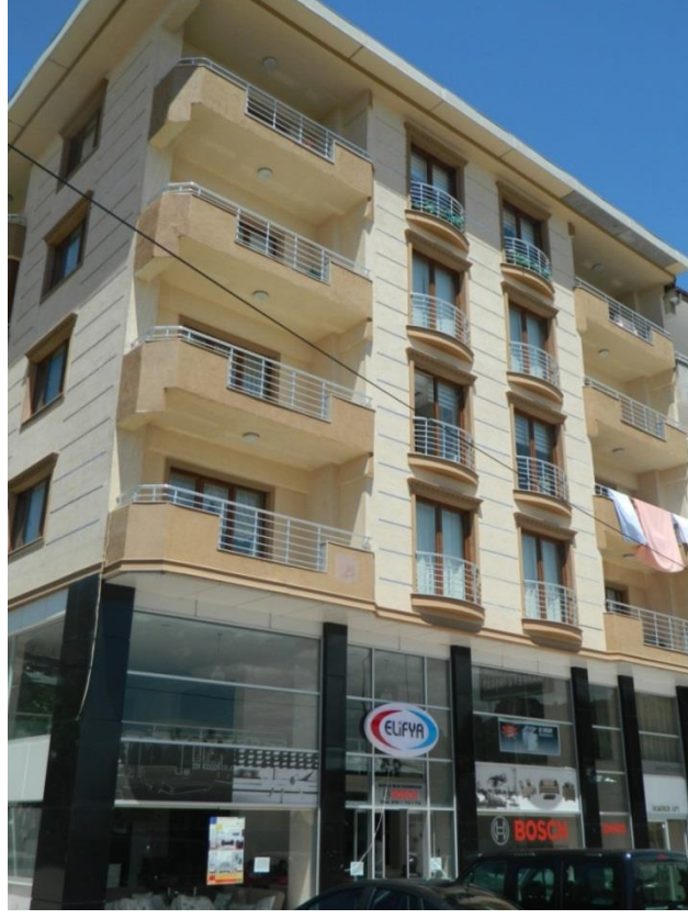
Şekil 8. Yumuşak katlı betonarme bina
