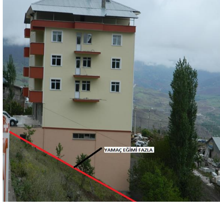
Şekil 16. Tepe yamaç etkisi olan betonarme bina
