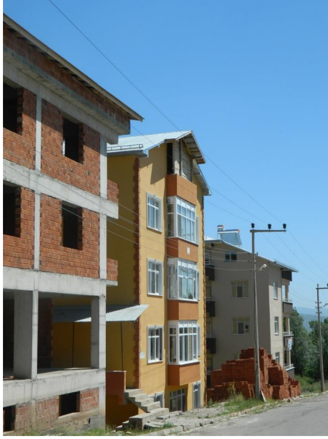
Şekil 13. Bant pencerenin kolon serbest boyunu kısaltması nedeniyle oluşan kısa kolonlu betonarme bina
