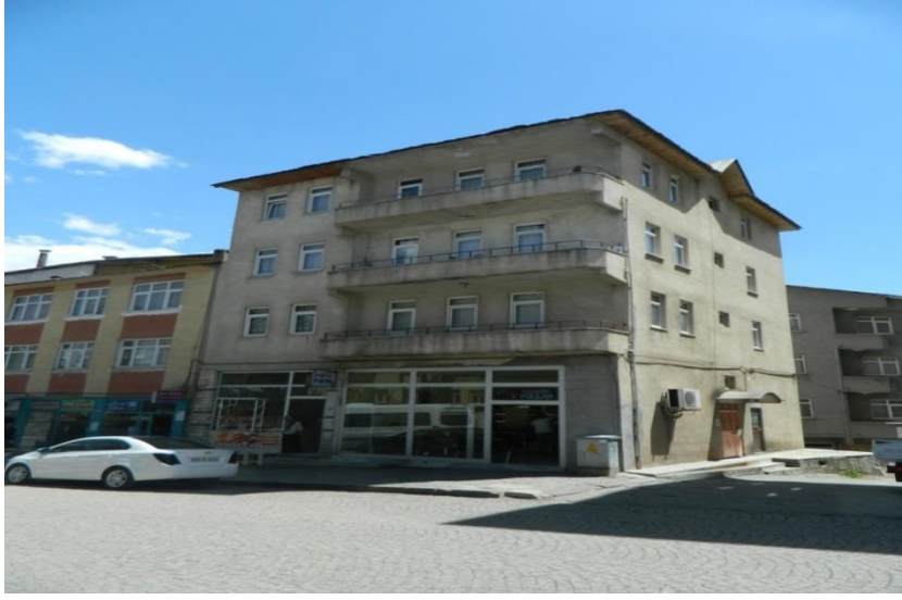
Şekil 11. Görünen yapı kalitesi orta olan betonarme bina
