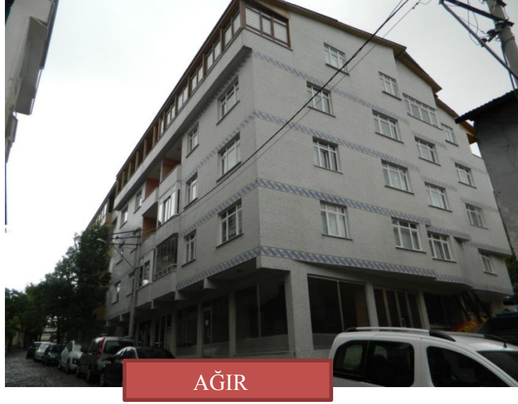
Şekil 9. Ağır çıkmalı betonarme bina
