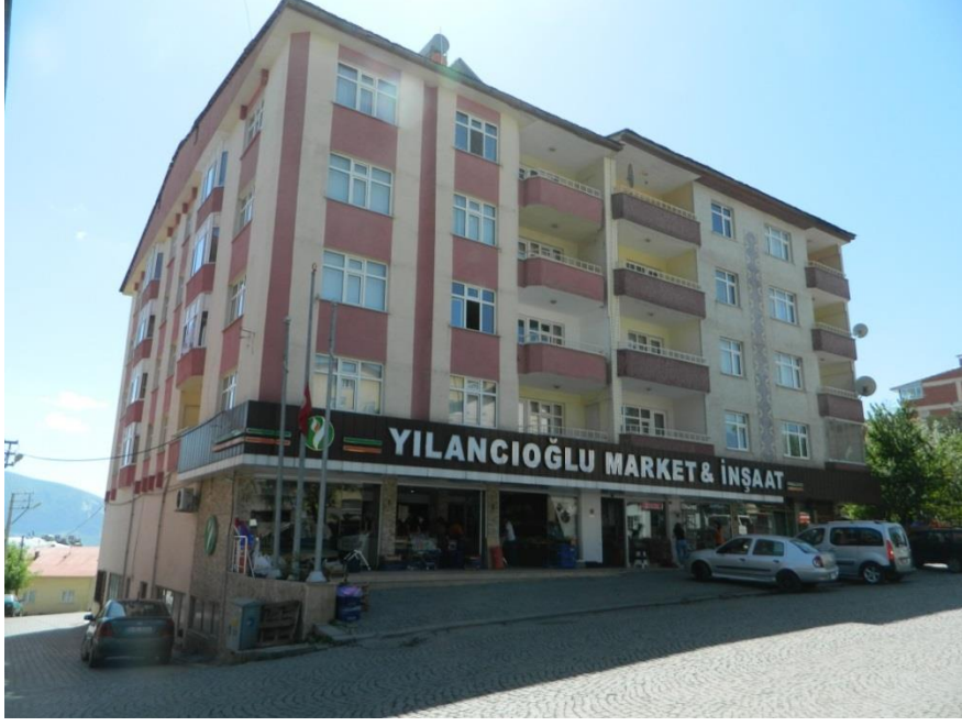
Şekil 7. Bodrum, zemin kat ve 4 normal kat toplam 6 katlı betonarme bina
