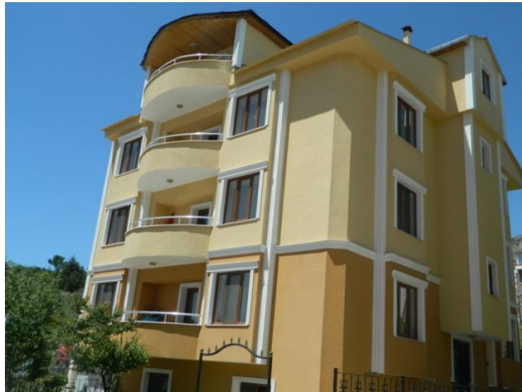
Şekil 10. Görünen yapı kalitesi iyi olan betonarme bina
