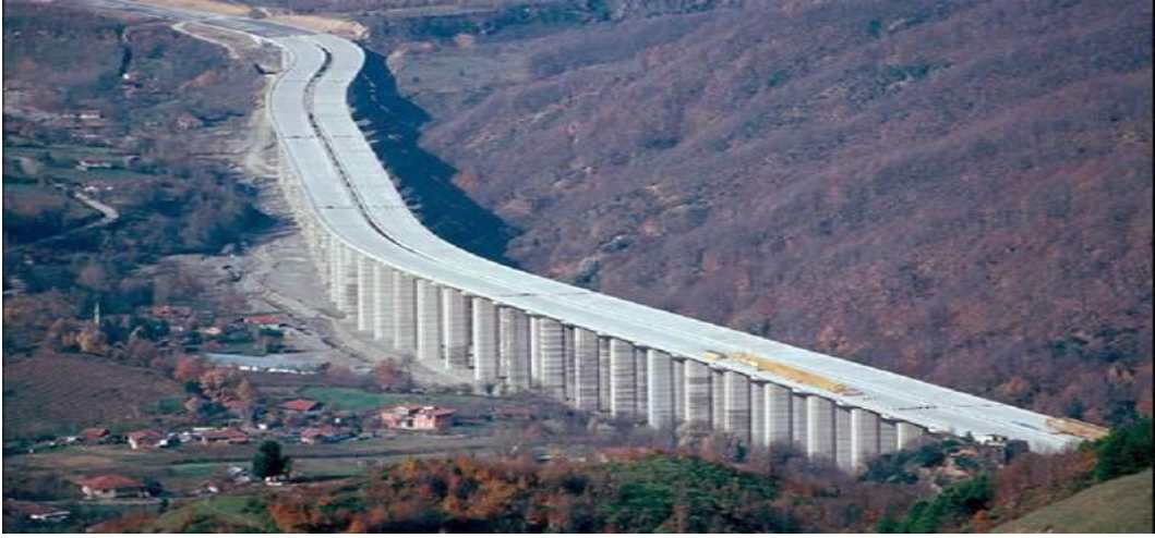
Şekil 1.10. Bolu viyadüğünde izolatör uygulaması
