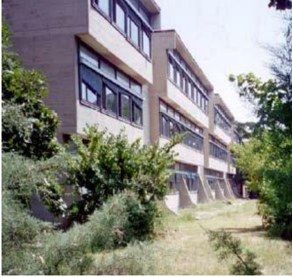
Şekil 1.11. 1969 yılında yapılan dünyanın ilk kauçuk sismik izolasyonlu binası
