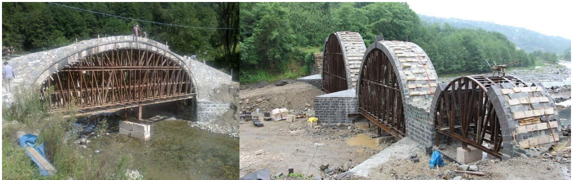
Şekil 1.12. Kemer köprü restorasyon çalışmaları (URL 11, 2015; URL 12, 2015)
