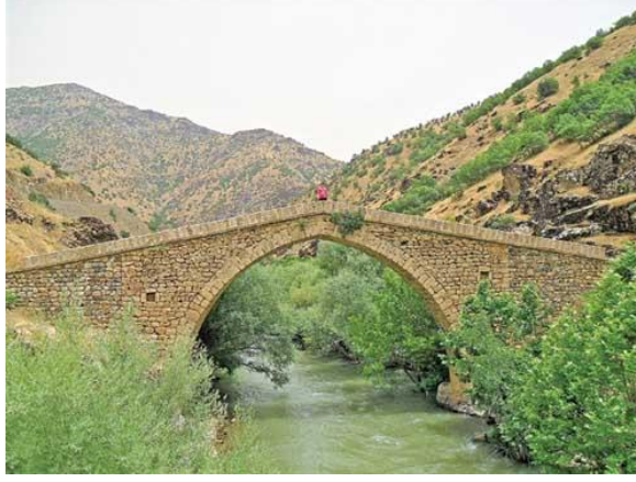
Şekil 1.10. Dik Köprü (Taş Köprü-Hakkari) (URL-8, 2015)
