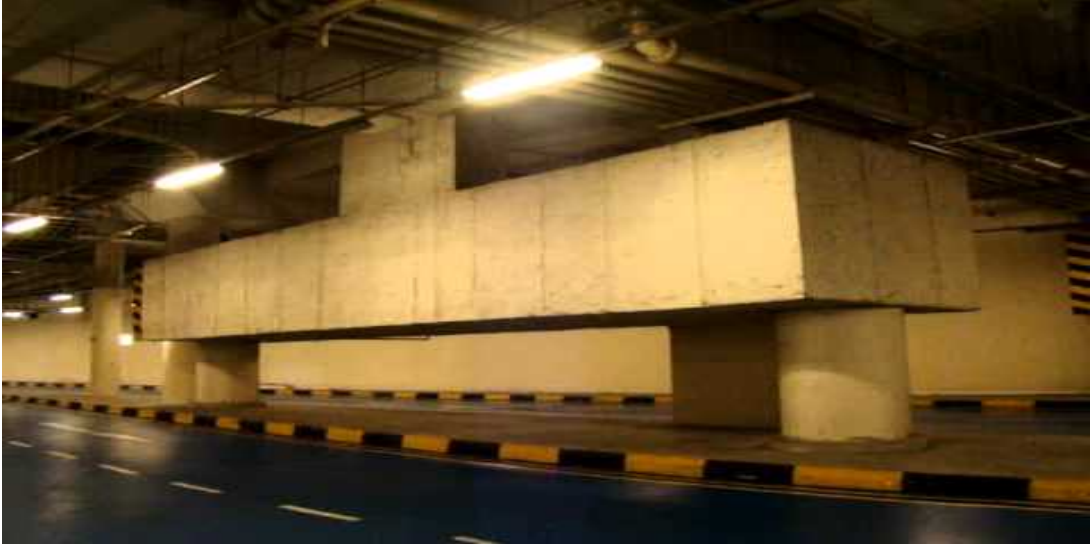
Şekil 4. Alt kata devam etmesi istenmeyen kolonun, transfer kiriş yardımıyla bodrum kata aktarılması [3]
