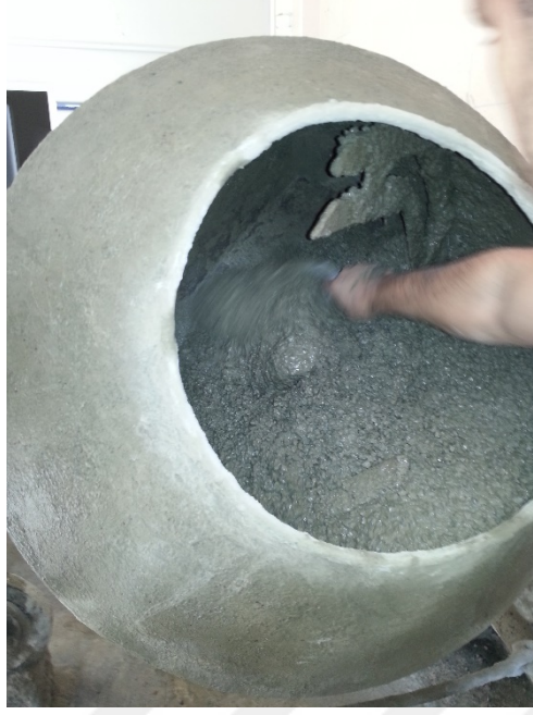
Şekil 43. Betonyer yardımıyla hazırlanan betona ait görünüm
