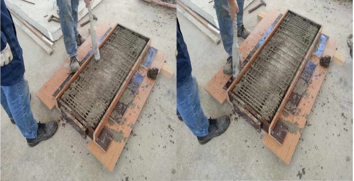
Şekil 44. Betona ve kalıba vibratör uygulaması
