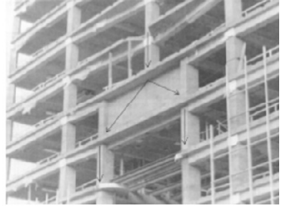
Şekil 2. Betonarme bir yapıda ara katta tek açıklıklı yüksek kiriş [2]
