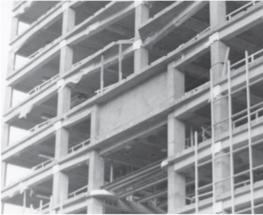
Şekil 2. Betonarme bir yapıda ara katta tek açıklıklı yüksek kiriş [2]
