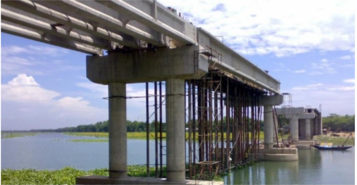
Şekil 9. Yüksek kirişlerin, başlık kirişi olarak köprüde kullanılmasına bir örnek [5]
