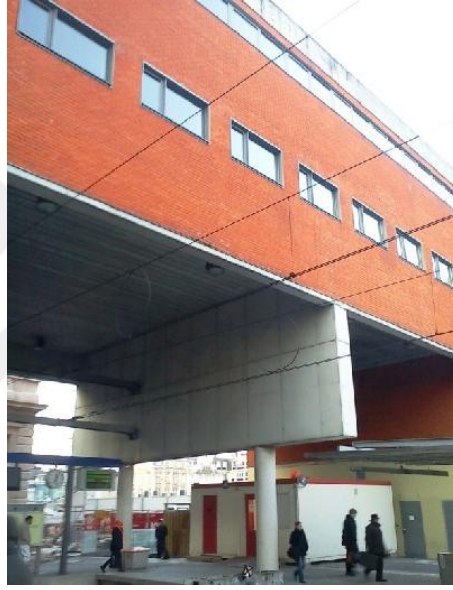
Şekil 1. Betonarme yüksek kiriş ile yüklerin kolonlara aktarılması [1]
