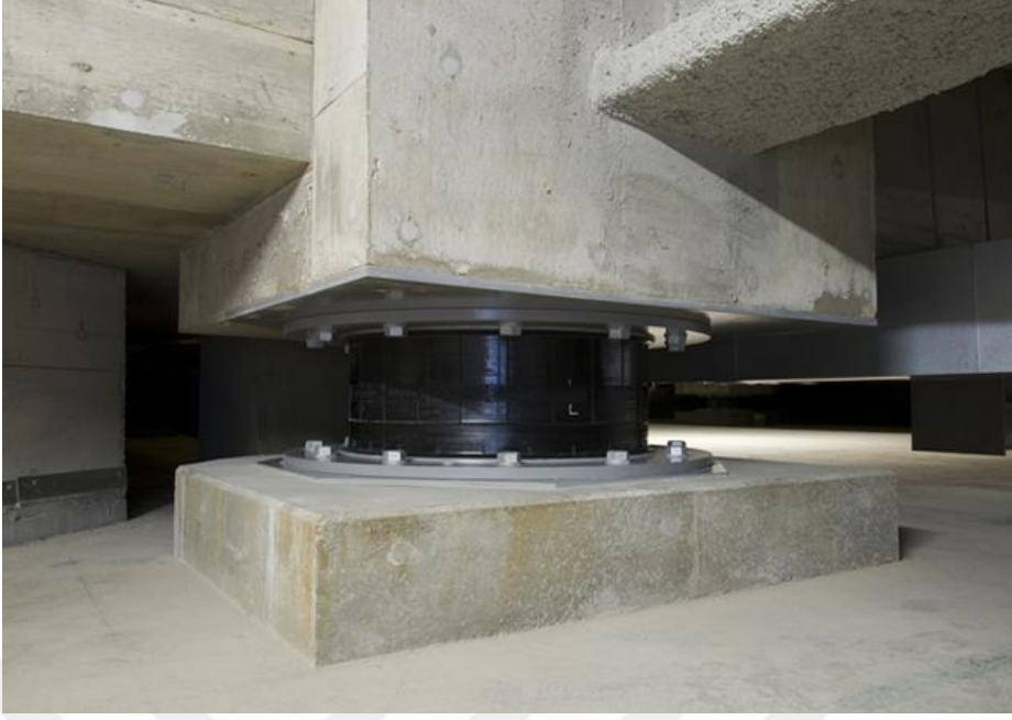
Şekil 1.1. Kolon tabanına yerleştirilen izolatör
