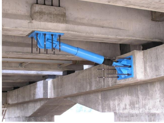
Őekil 1.4. Viskoz akıřkanlı sönümleyici
