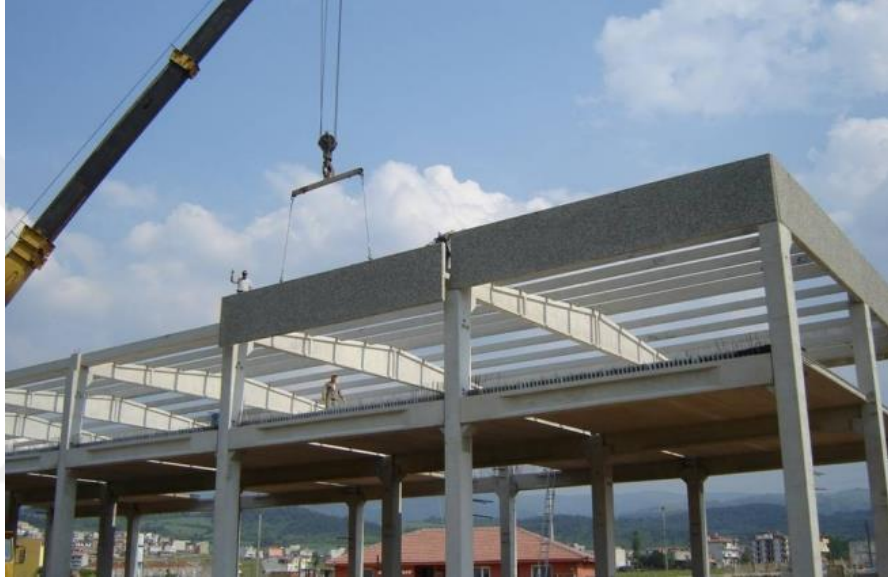
Şekil 1.9. Kolon-döşeme sistemi
