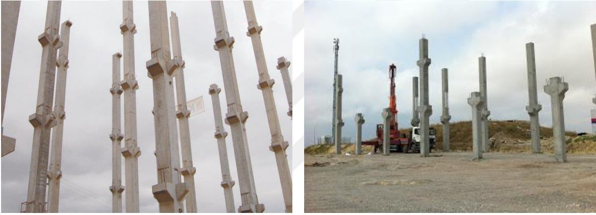
Şekil. 1.4. Prefabrik kolonlara ait çeşitli örnekler (URL-1)
