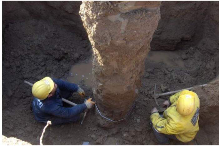
Şekil 36. Jet grout kolonu çap kontrolü (URL-5).
