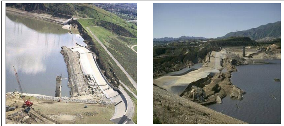
Şekil 7. Aşağı San Fernando Barajı'nda 9 Şubat 1971'de meydana gelen depremden sonraki akma türü sıvılaşma (Kramer, 1996).
