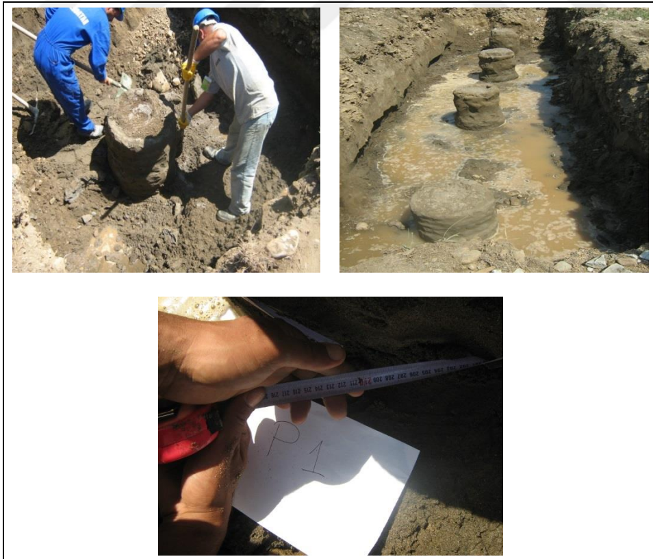
Şekil 61. Jet grout kolonu pilot çalışma
