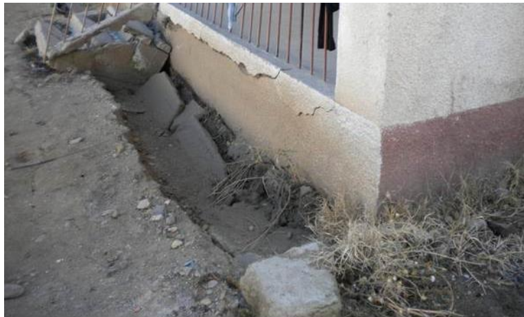
Şekil 17. 23 Ekim 2011 Van Depremi'nde sıvılaşmaya bağlı zemin oturması (URL-3).
