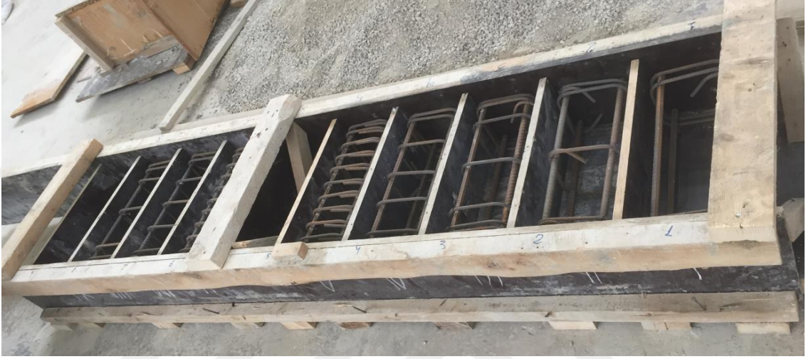
Şekil 2.8. Hazırlanan kalıp ve donatıların beton döküm öncesi görünümü
