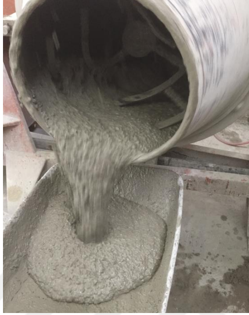
Şekil 2.9 Taze betonun betonyerden alınması
