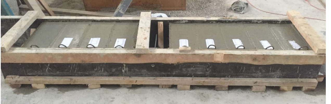
Şekil 2.12. Kalıpların betonlama işleminden sonraki görünümü
