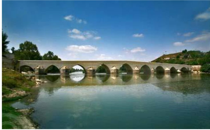
Şekil 1.13. Misis Köprüsü, Adana (URL-6, 2017)
