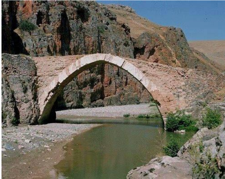
Şekil 1.11. Karamağara Köprüsü (URL-4, 2017)
