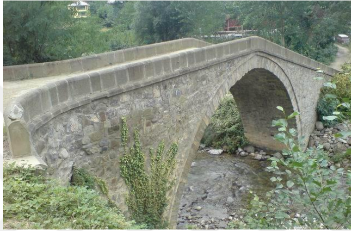
Şekil 1.18. Coşandere Köprüsü, Trabzon (URL-9, 2017)
