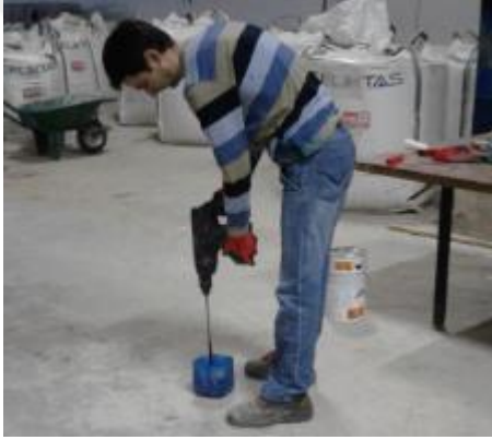
e) Epoksi esaslı yapıştırıcının hazırlanması ve eleman yüzelerindeki pürüzlerin giderilmesi
