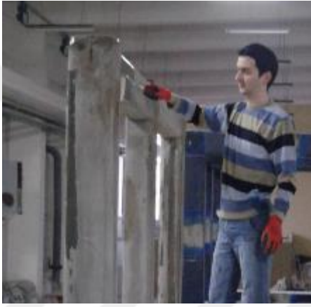
b) Astar malzemesinin elemanlara sürülmesi
