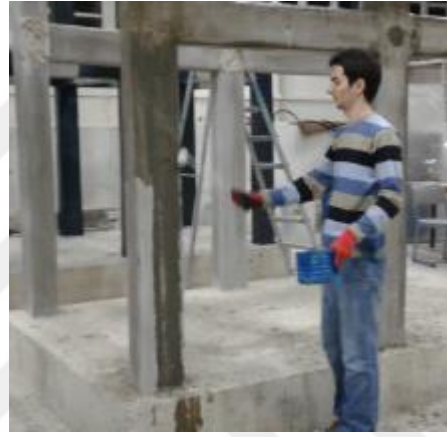
b) Astar malzemesinin elemanlara sürülmesi
