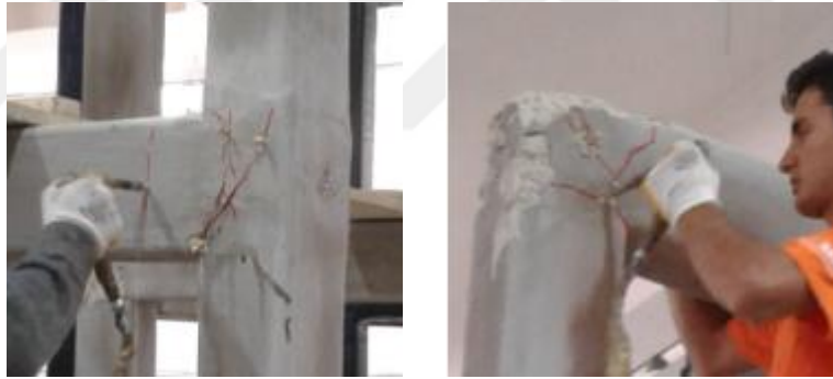
c) Enjeksiyon malzemesinin basınç ile pakerlerden çatlaklara enjekte edilmesi
