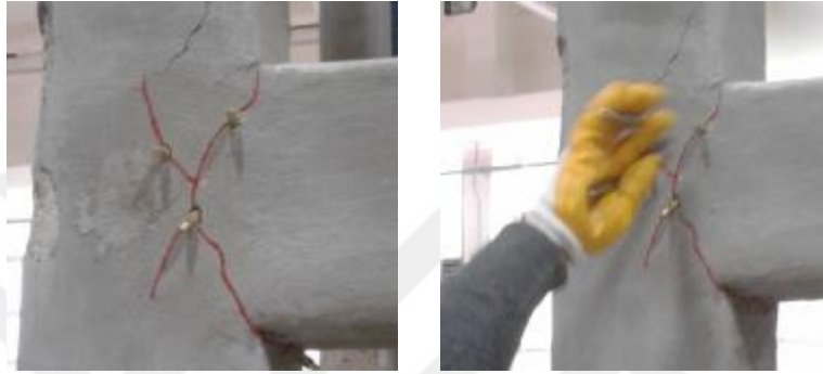
b) Pakerlerin deliklere çakılması ve sıkıştırılması
