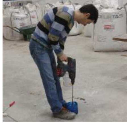
a) Astar malzemesinin hazırlanması
