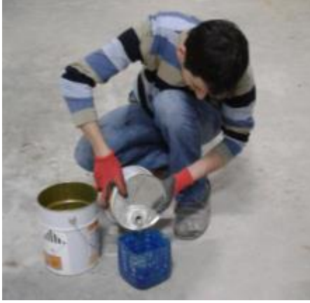
a) Astar malzemesinin hazırlanması
