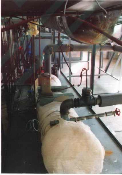
řekil 3.11. Su Kaynaklı Evaporatör.
