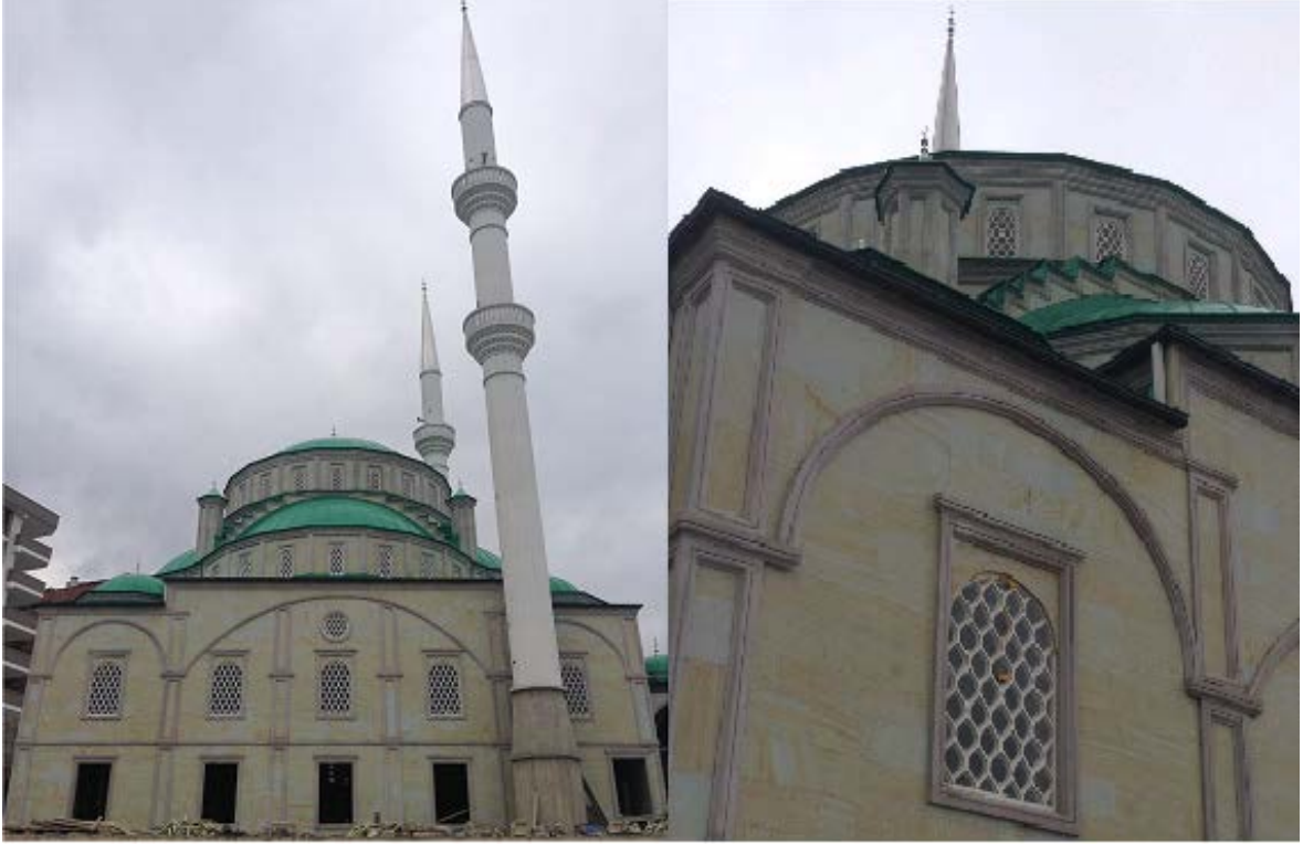
Şekil 2.9. Trabzon Zafanoz Camii ve dış kaplamasındaki BYT kullanımını detayı
