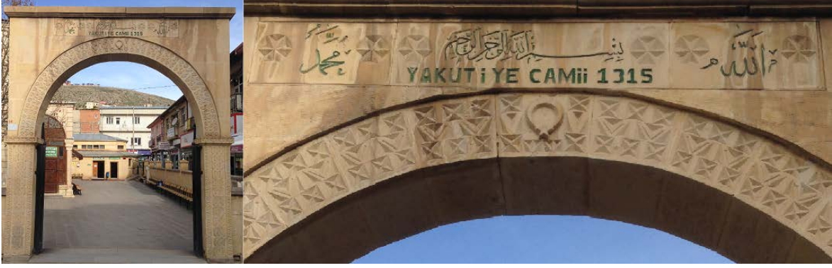
Şekil 2.17. Bayburt Yakutiye Camii kemerleri ve BST kullanımı detayı
