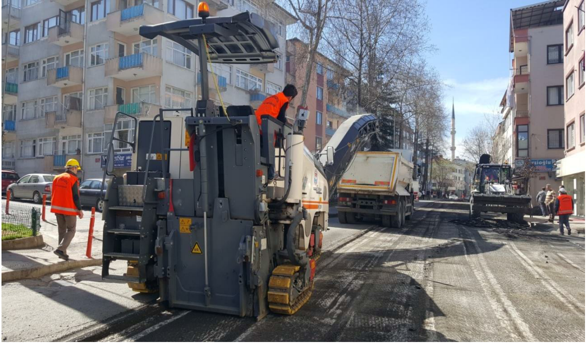
řekil 8. RAP malzemesinin kazınarak kamyonla yüklenmesi
