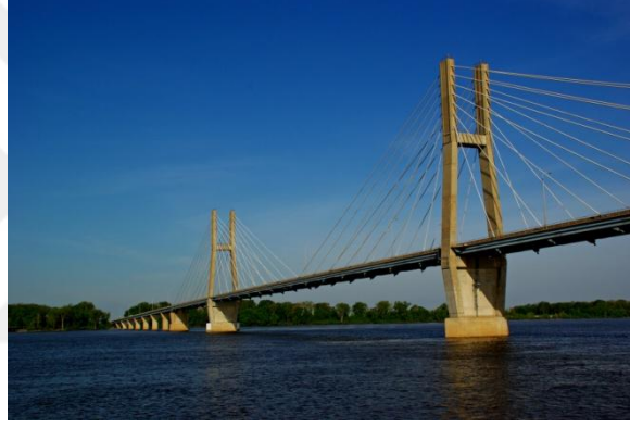
Şekil 3.5. Quincy Bayview Köprüsü
