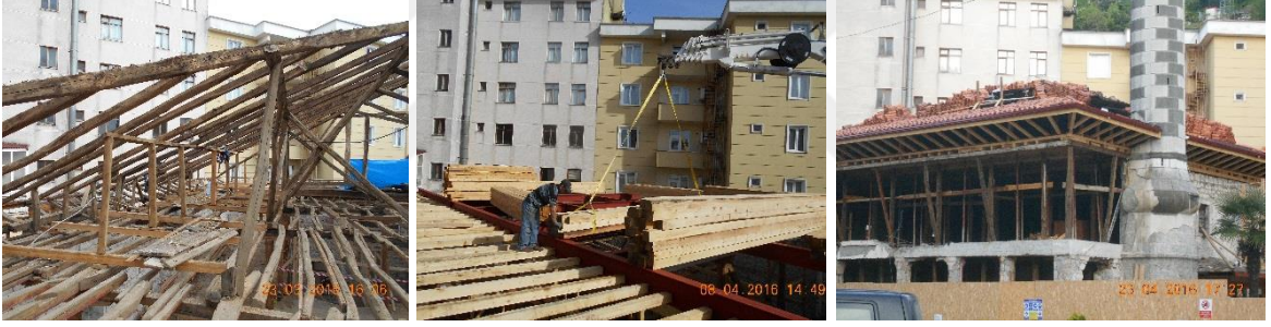
Şekil 2.70. Hacıbaşı Camii çatı imatları
