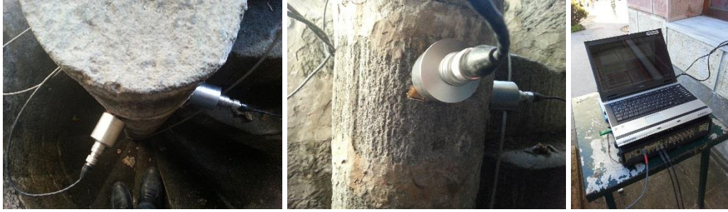
Şekil 2.81. Hacıbaşı Camii Minaresi restorasyon öncesi ölçüm görüntüleri
