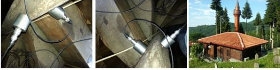
Şekil 2.363. Bereketli Masele Camii Minaresi restorasyon sonrası ölçüm görüntüleri
