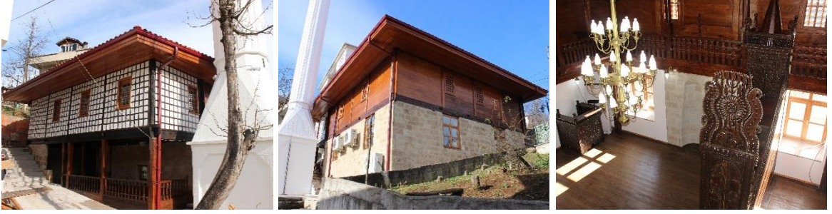
Şekil 2.368. Günebakan Camii restorasyon sonrası görüntüleri
