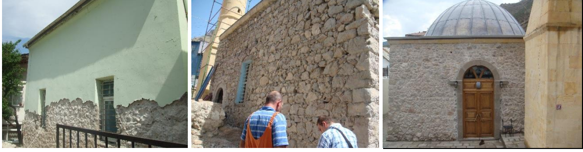
Şekil 2.288. Emirler Camii dış cephe imalatı görüntüleri
