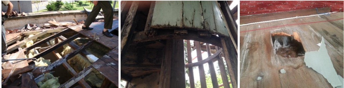
Şekil 1.20. Ahşap malzemede küf ve böceklenme örnekleri
