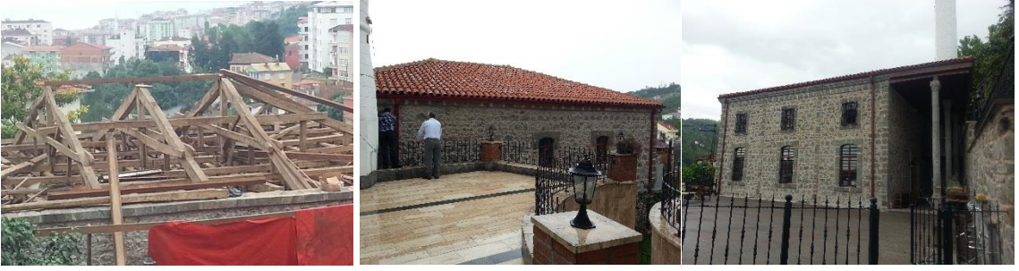
Şekil 2.26. Orta Mahalle Camisi çatı imatları
