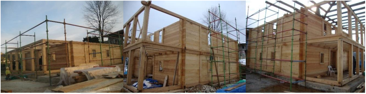
Şekil 2.386. Kuşluca Camii beden duvarı imatları
