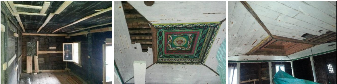
Şekil 2.369. Günebakan Camii söküm işlemlerine ilişkin görüntüler
