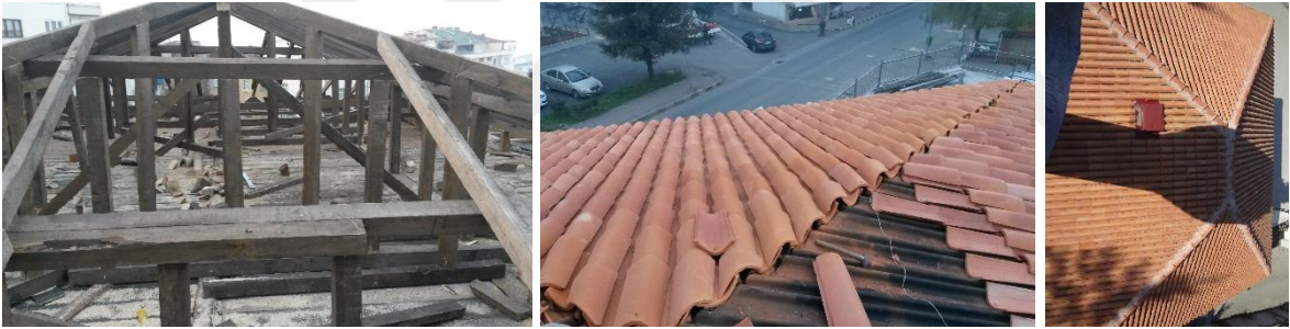
Şekil 2.160. Tahtalı Camii çatısı yapım aşamaları
