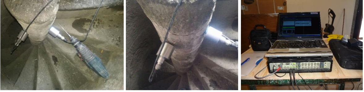
Şekil 2.83. Hacıbaşı Camii Minaresi restorasyon sonrası ölçüm görüntüleri
