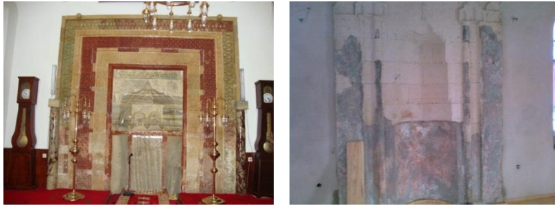
Şekil 1.18. Tuzlanma ve asitlenme örnekleri
