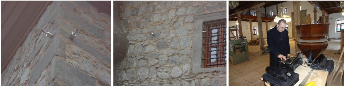
Şekil 2.78. Hacıbaşı Camii restorasyon sonrası ölçüm görüntüleri
