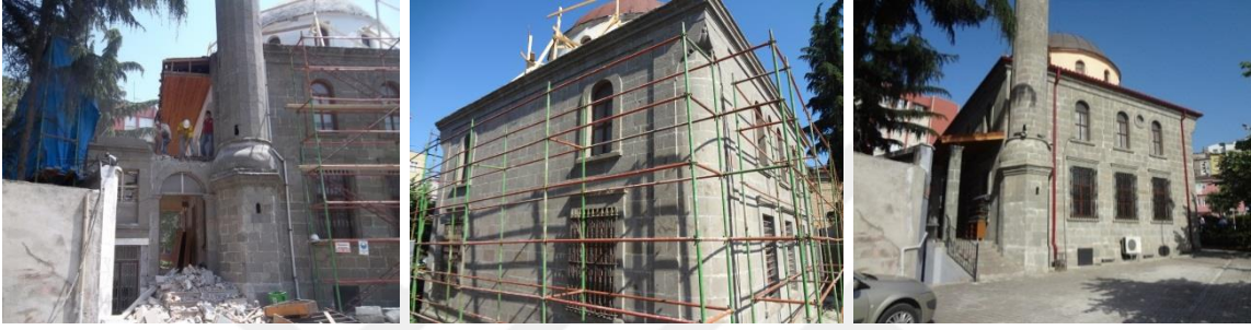
Şekil 2.209. Hacı Kasım Camisi restorasyon aşamasına ait görüntüler
