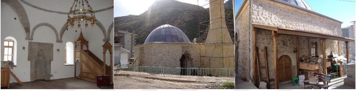
Şekil 2.287. Emirlers Camii genel restorasyon görüntüleri
