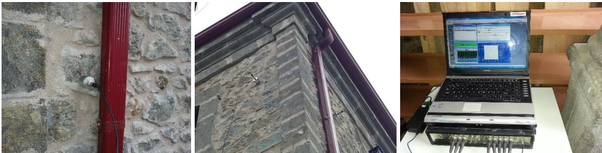
Şekil 2.35. Orta Mahalle Camisi restorasyon sonrası ölçüm görüntüleri
