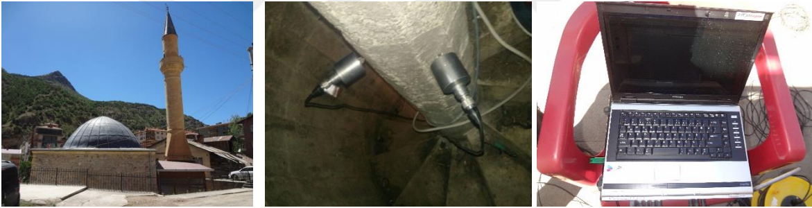
Şekil 2.294. Emirler Camii Minaresi restorasyon sonrası ölçüm görüntüleri
