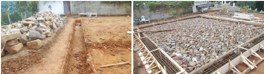
Şekil 2.387. Kuşluca Camii beden duvar altı temel kiriş imatları
