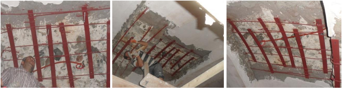
Şekil 2.325. Küçük Fatih Camii tonoz güçlendirme işlemleri
