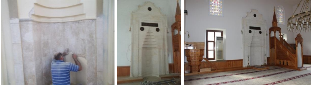
Şekil 2.210. Hacı Kasım Camii mihrap temizliği
