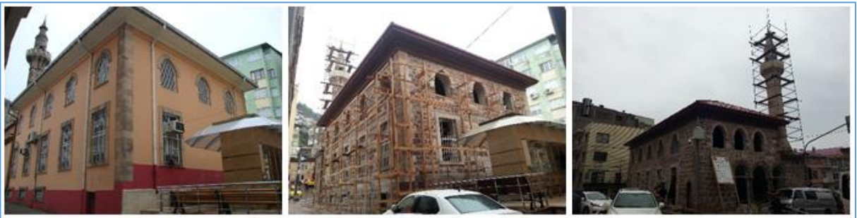
Şekil 2.197. Çınarlar Camii cephe işleri görüntüleri
