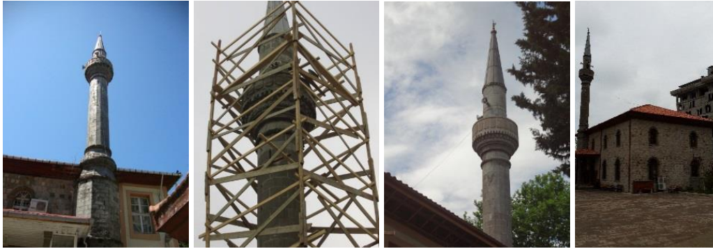
Şekil 2.7. Büyük Gülbahar Camii minare onarımı görüntüleri
