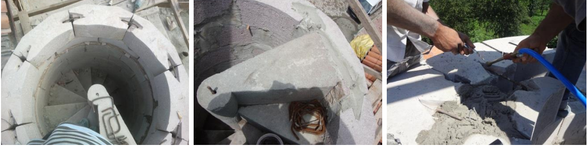
Şekil 1.25. Geleneksel yığma taş minare yapım görüntüleri
