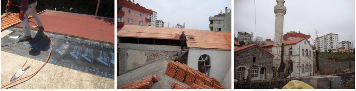
Şekil 2.324. Küçük Fatih Camii çatı imalatları
