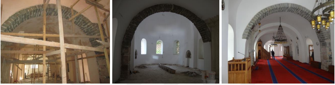
Şekil 2.326. Küçük Fatih Camii iç mekân uygulamaları
