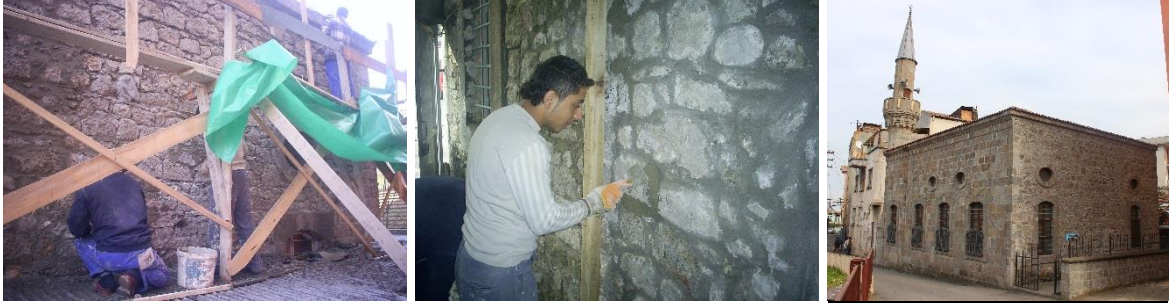
Şekil 2.138. Hoca Halil Camisi cephe derz imalatları görüntüleri
