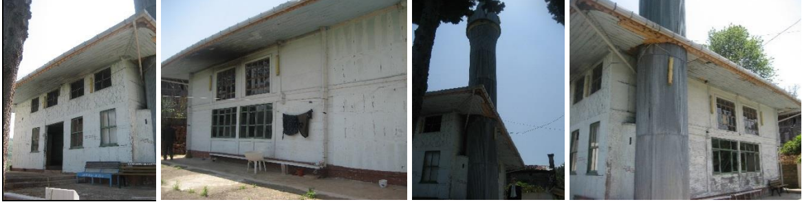
Şekil 2.383. Kuşluca Camii restorasyon öncesi görüntüleri
