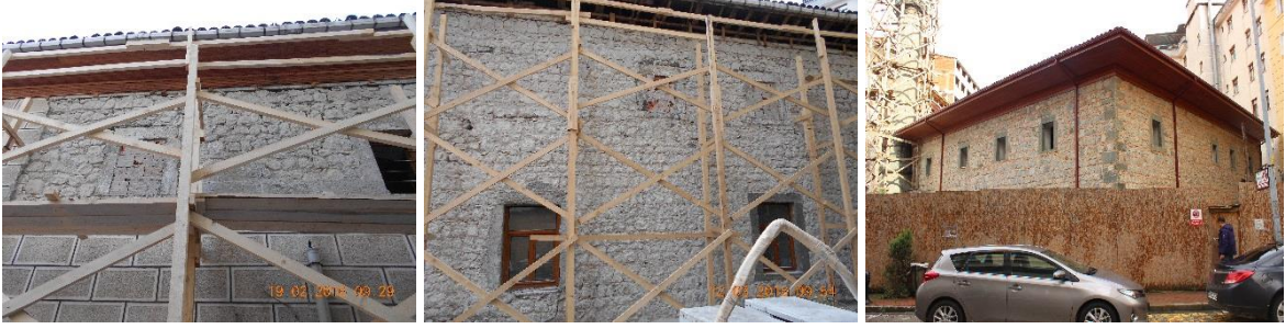
Şekil 2.71. Hacıbaşı Camii cephe imalatları
