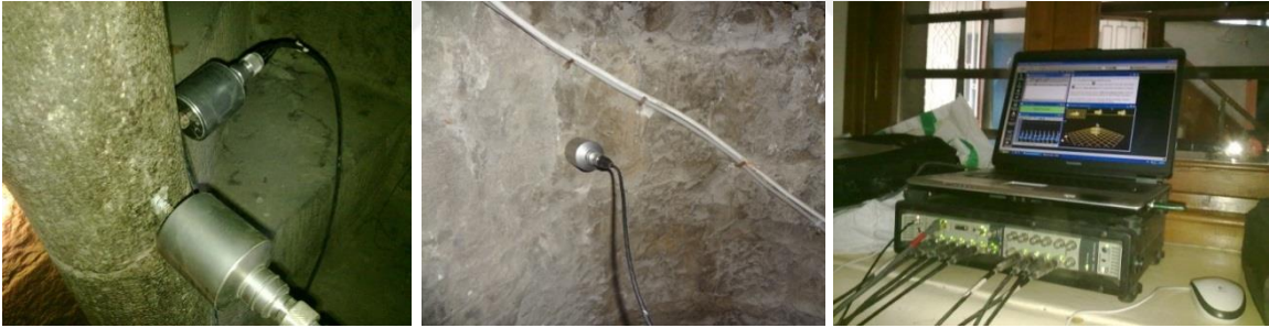
Şekil 2.226. Hacı Kasım Camii Minaresi restorasyon öncesi ölçüm görüntüleri
