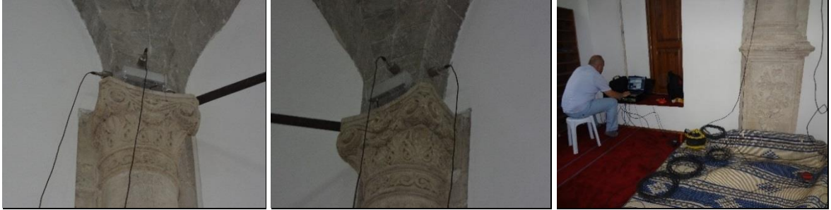
Şekil 2.266. Kapu Camii restorasyon sonrası ölçüm görüntüleri
