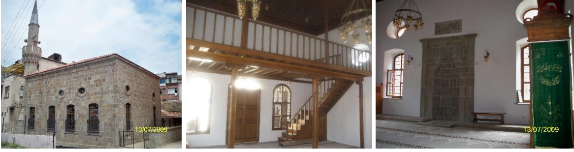
Şekil 2.135. Hoca Halil Camisi onarım sonrası görüntüleri
