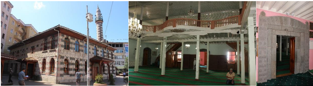
Şekil 2.68. Hacıbaşı Camii restorasyon öncesi görüntüleri
