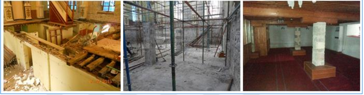
Şekil 2.265. Kapu Camii bodrum kat imalatları
