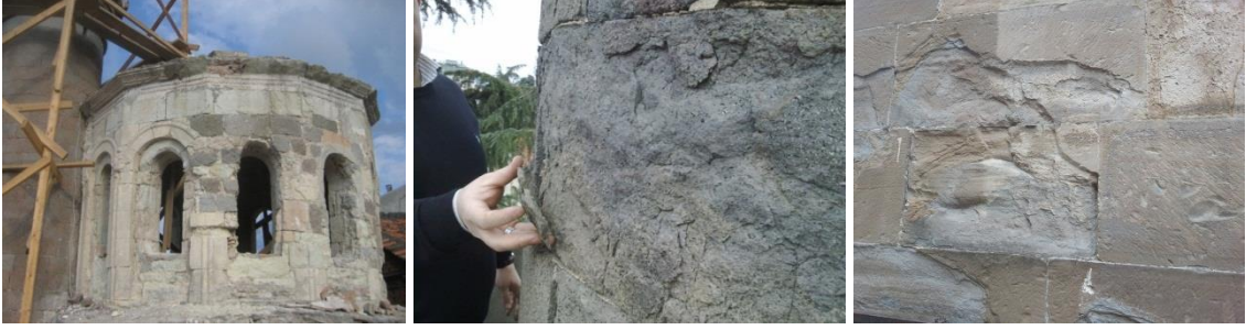
Şekil 1.17. Taş erimesi örnekleri
