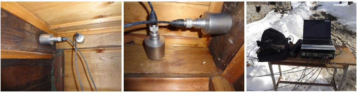
Şekil 2.429. Düzköy Camii restorasyon sonrası ölçüm görüntüleri
