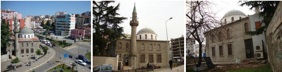
Şekil 2.205. Hacı Kasım Camii restorasyon öncesi görüntüleri
