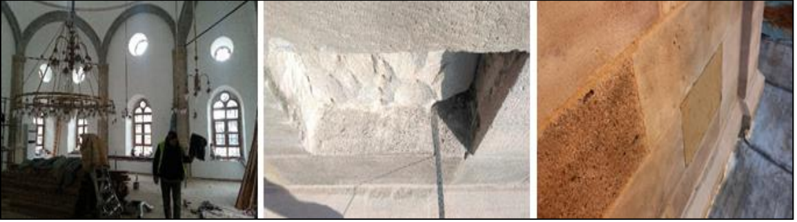
Şekil 2.264. Kapu Camii taş imalatları
