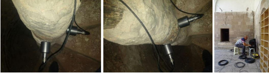
Şekil 2.256. Behramşah Camii Minaresi restorasyon öncesi ölçüm görüntüleri
