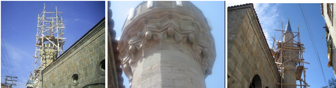
Şekil 2.139. Hoca Halil Camisi minare onarımı görüntüleri
