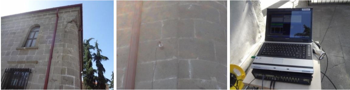
Şekil 2.221. Hacı Kasım Camii restorasyon sonrası ölçüm görüntüleri
