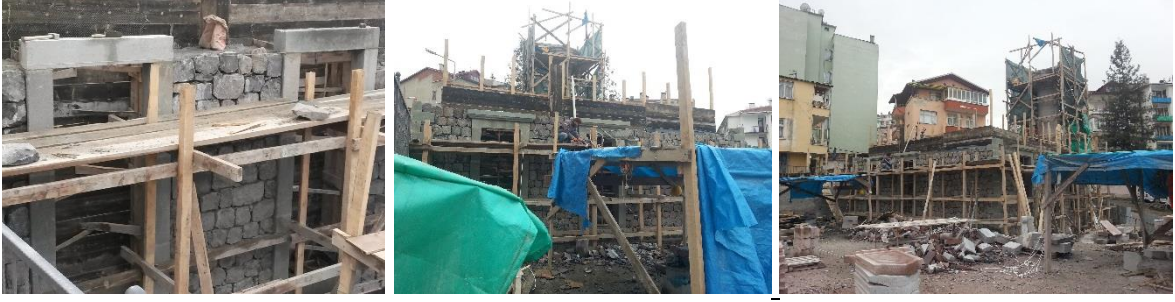
Şekil 2.159. Cami beden duvarları yapım aşamaları
