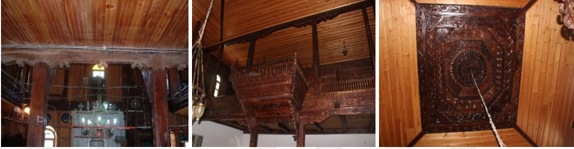
Şekil 2.404. Taşkiran Camii tavan imalatları
