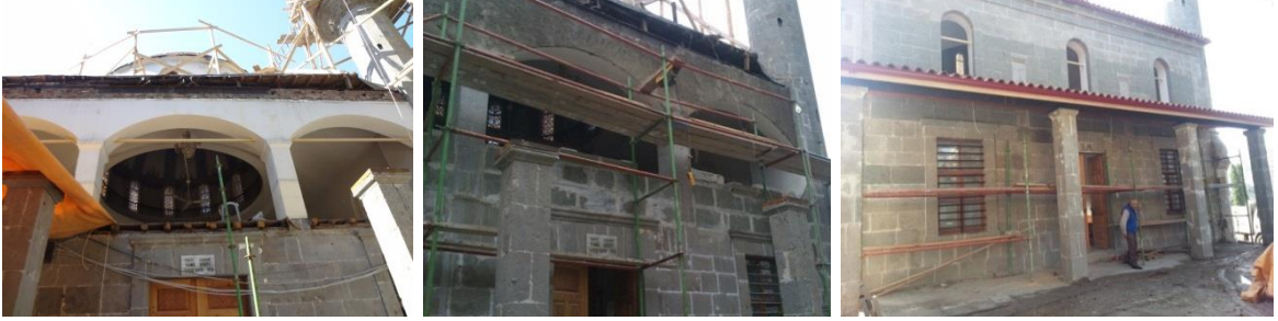
Şekil 2.214. Hacı Kasım Camii kuzey cephe imalatları
