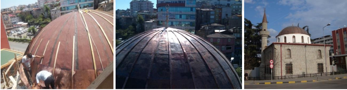
Şekil 2.212. Hacı Kasım Camii kubbe onarımı
