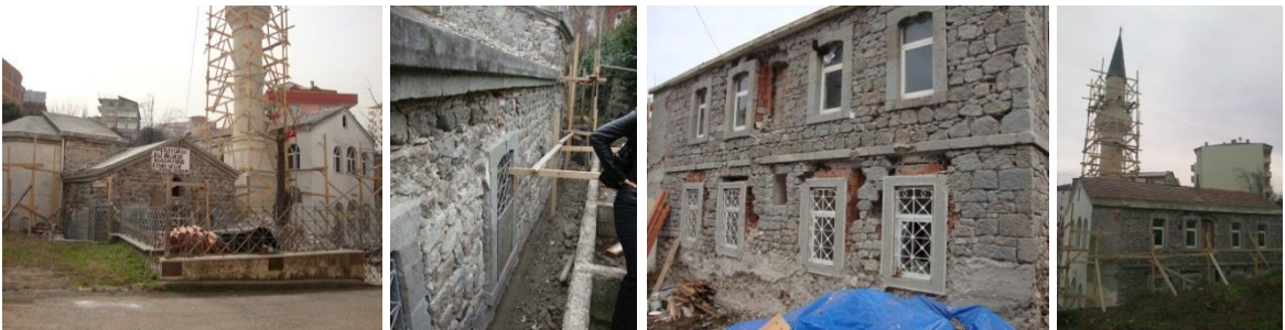
Şekil 2.327. Küçük Fatih Camii dış cephe uygulamaları
