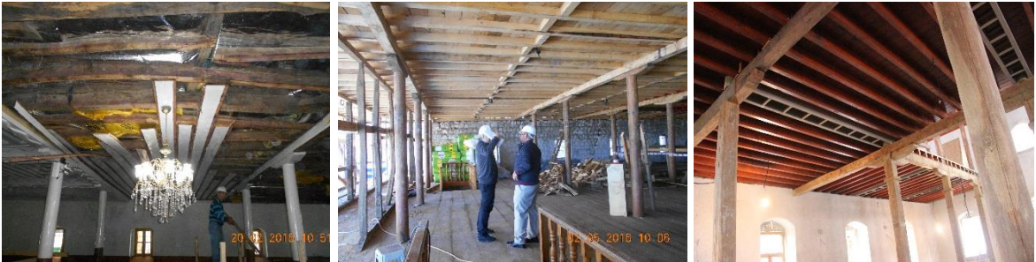
Şekil 2.72. Hacıbaşı Camii harim ve son cemaat ahşap kargas sistemi
