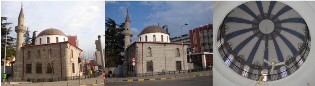
Şekil 2.208. Hacı Kasım Camii restorasyon sonrası görüntüleri
