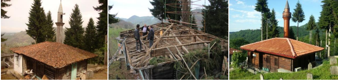
Şekil 2.348. Bereketli Masele Camii çatı imalatları
