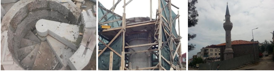
Şekil 2.161. Tahtalı Camii Minaresi yapım aşamaları
