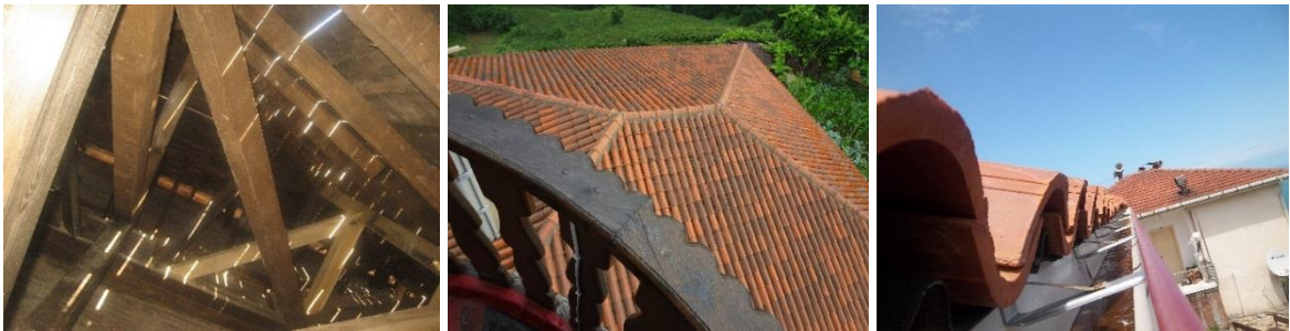
Şekil 2.390. Kuşluca Camii çatı imalatları
