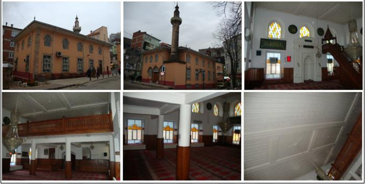
Şekil 2.192. Çınarlar Camii restorasyon öncesi görüntüleri
