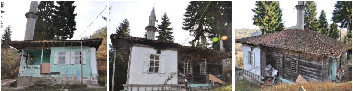
Şekil 2.344. Bereketli Masele Camii restorasyon öncesi görüntüleri
