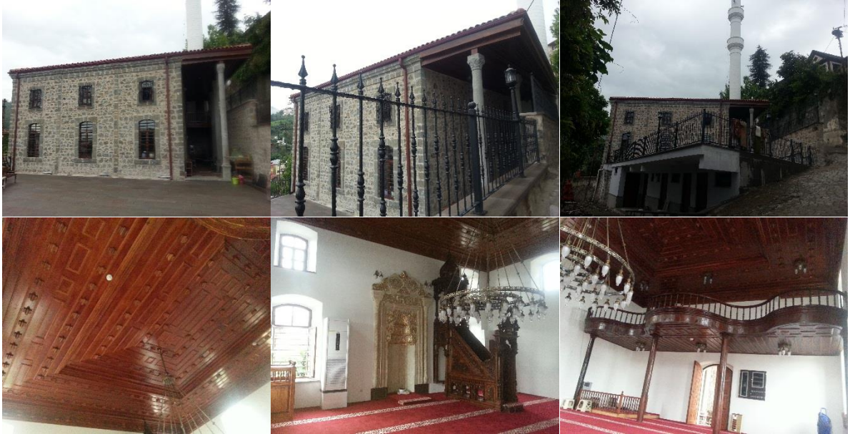
Şekil 2..25. Orta Mahalle Camisi restorasyon sonrası görüntüleri
