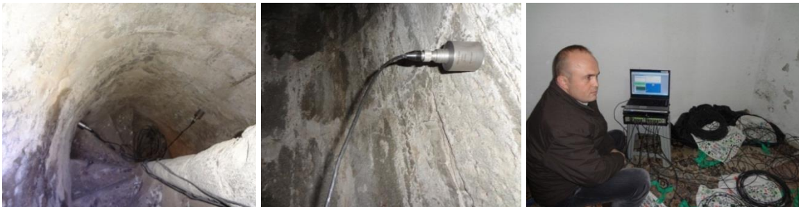
Şekil 2.16. Büyük Gülbahar Camii Minaresi restorasyon öncesi ölçüm görüntüleri
