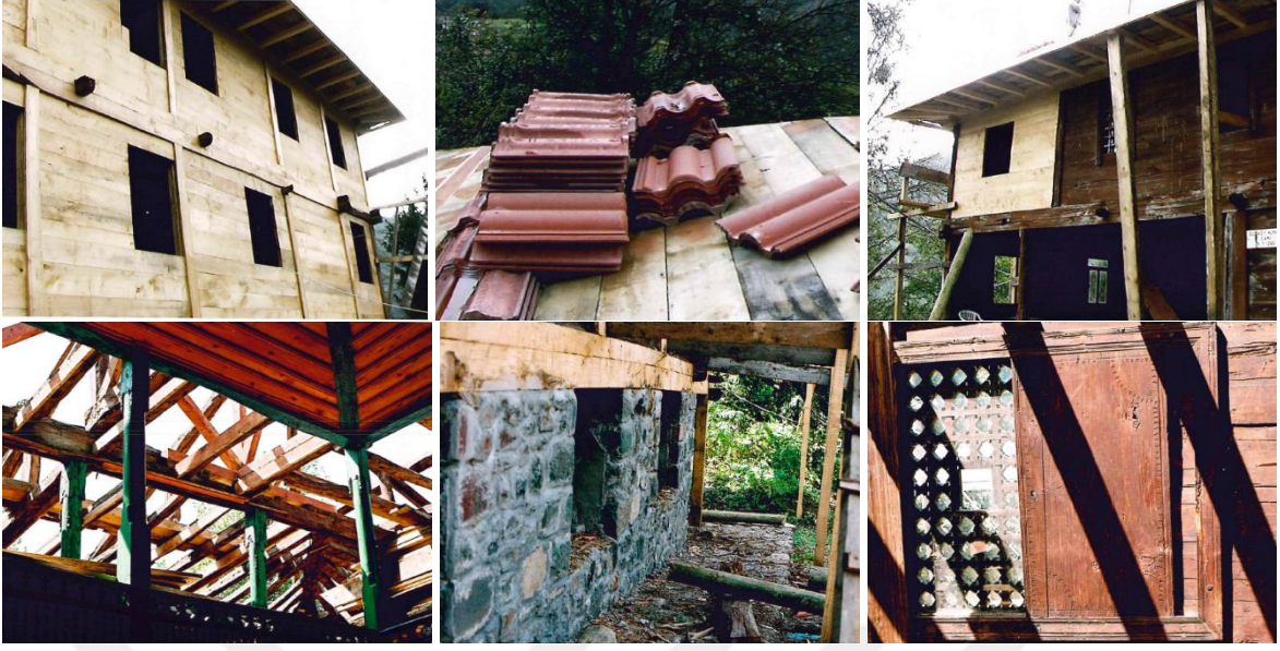
Şekil 2.428. Düzköy Camii restorasyon işlemlerine ait görüntüler
