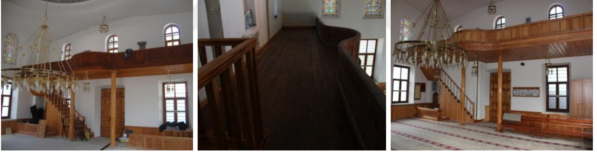
Şekil 2.215. Hacı Kasım Camii mahfil katı imalatları
