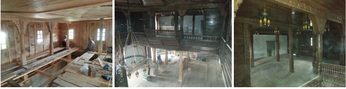
Şekil 2.417. Taşören Camii iç mekân imalatları
