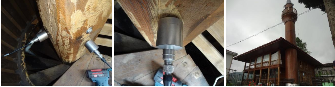
Şekil 2.396. Kuşluca Camii Minaresi restorasyon sonrası ölçüm görüntüleri
