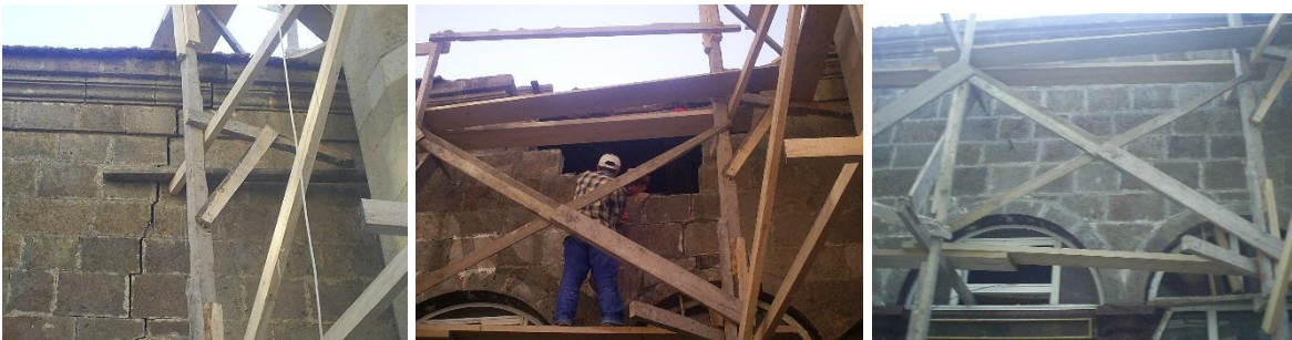
Şekil 2.136. Hoca Halil Camisi duvar çatlakları onarım görüntüleri
