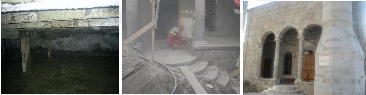
Şekil 2.137. Hoca Halil Camisi döşeme ve yüzey temizliği görüntüleri
