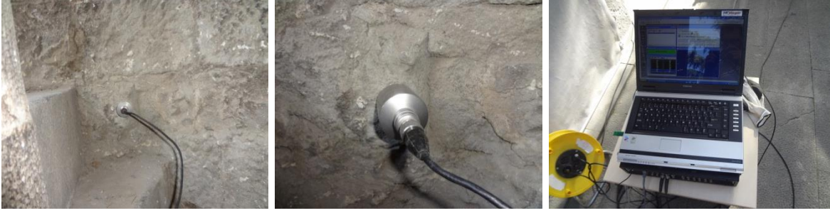
Şekil 2.228. Hacı Kasım Camii Minaresi restorasyon sonrası ölçüm görüntüleri
