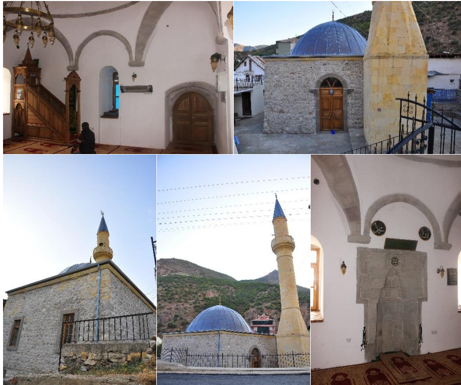
Şekil 2.289. Emirler Camii restorasyon sonrası görüntüleri
