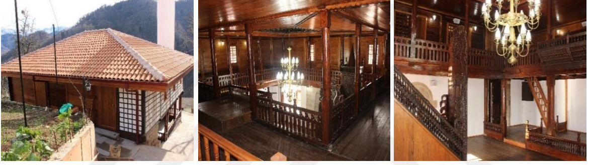
Şekil 2.372. Günebakan Camii restorasyon sonrası görüntüleri
