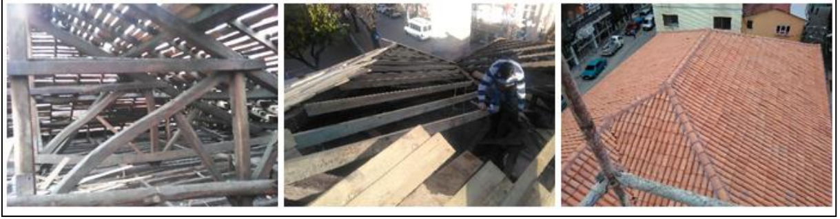
Şekil 2.194. Çınarlar Camii çatı onarımı görüntüleri
