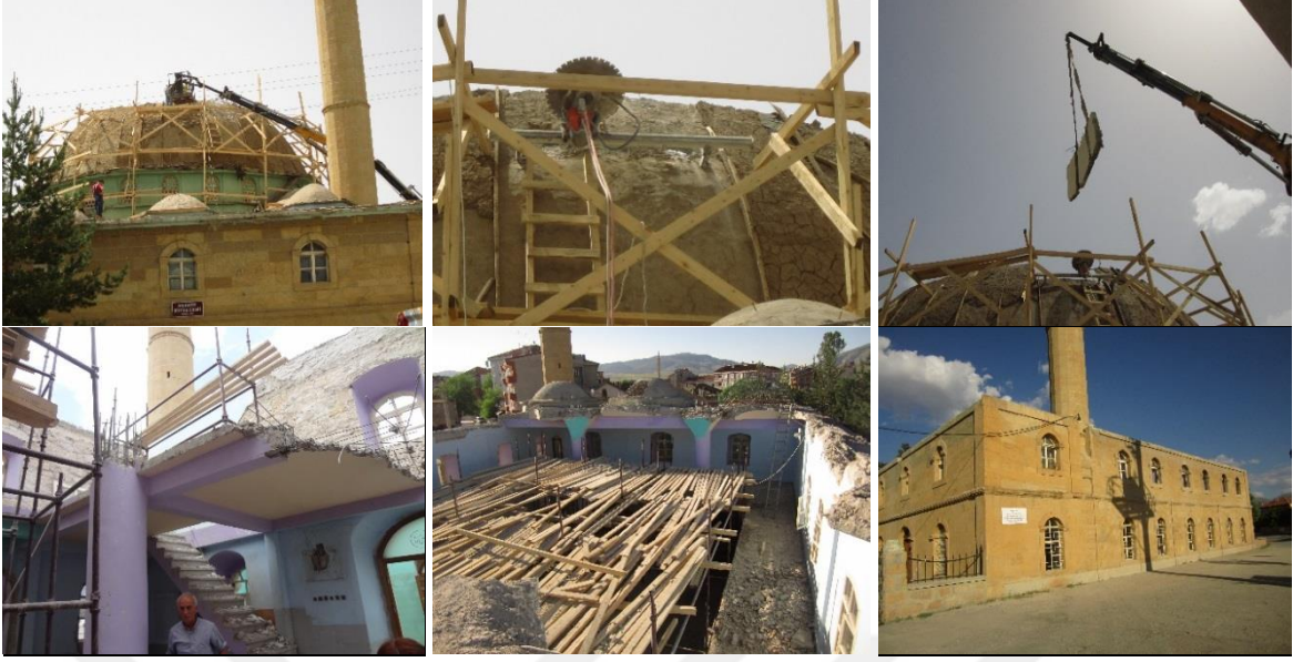
Şekil 2.181. Kelkit Büyük Camii betonarme elemanların sökümün görüntüleri
