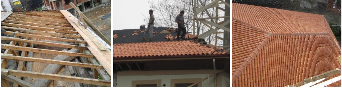
Şekil 2.5. Büyük Gülbahar Camisi çatı onarımına ilişkin görüntüler
