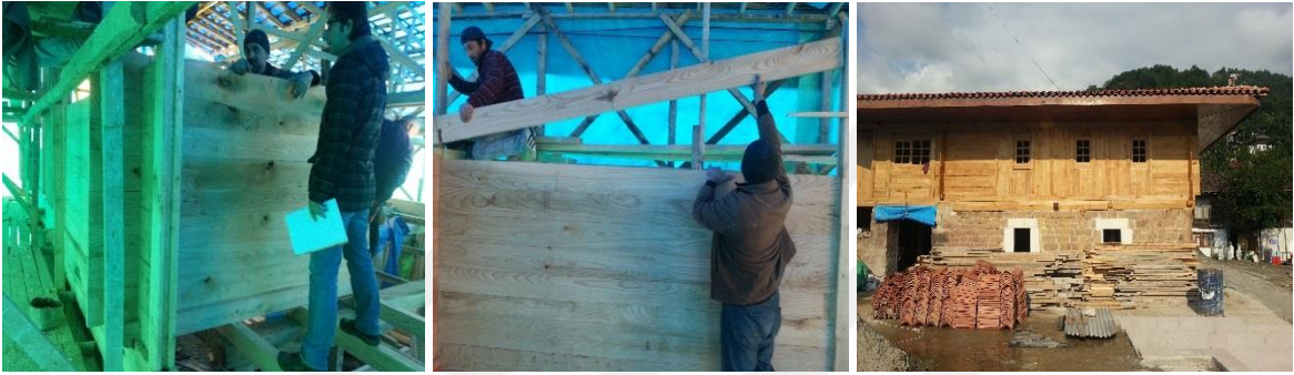
Şekil 2.416. Taşören Camii boğaz geçmeli ahşap duvar imalatı
