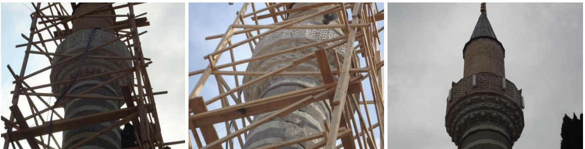
Şekil 2.123. Tavanlı Camii Minaresinin restorasyonuna ait görüntüler
