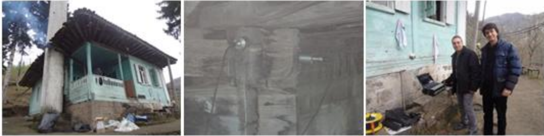
Şekil 2.353. Bereketli Masele Camii restorasyon öncesi ölçüm görüntüleri
