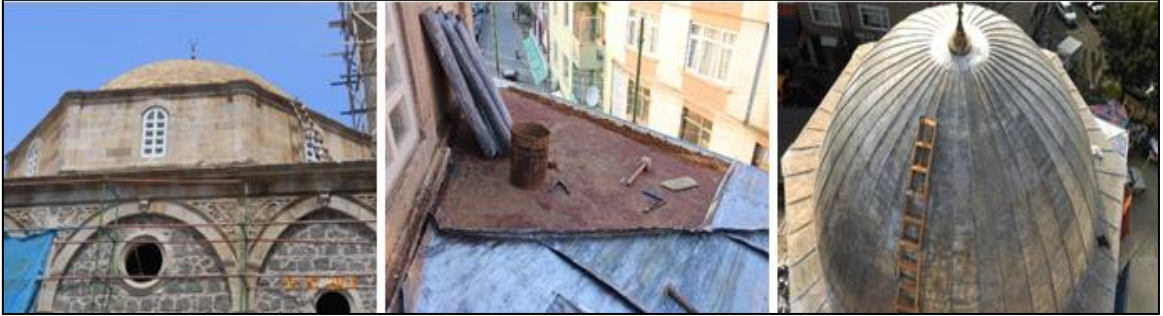
Şekil 2.262. Kapu Camii kurşun kaplama imalatları
