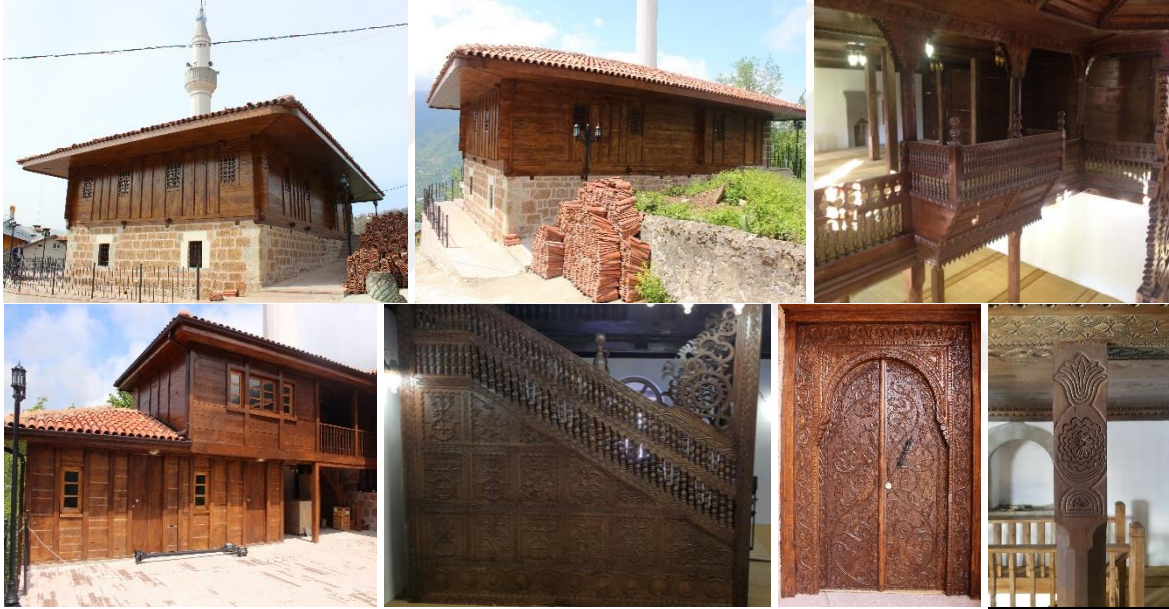
Şekil 2.415. Taşören Camii restorasyon sonrası görüntüleri
