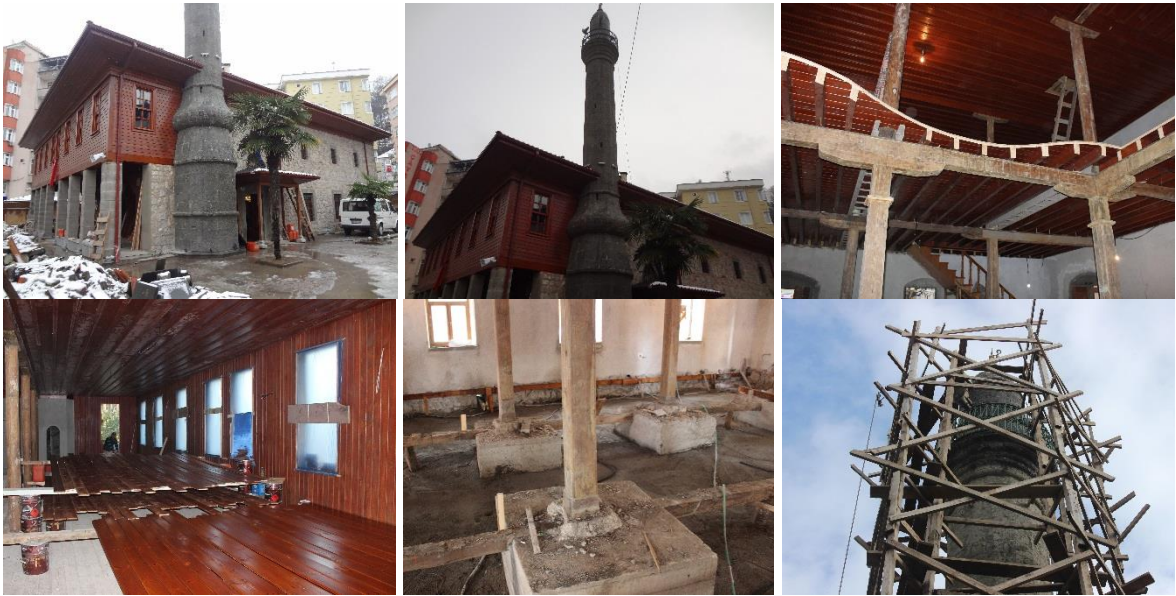
Şekil 2.69. Hacıbaşı Camii restorasyonuna ait dış ve iç mekân görüntüleri
