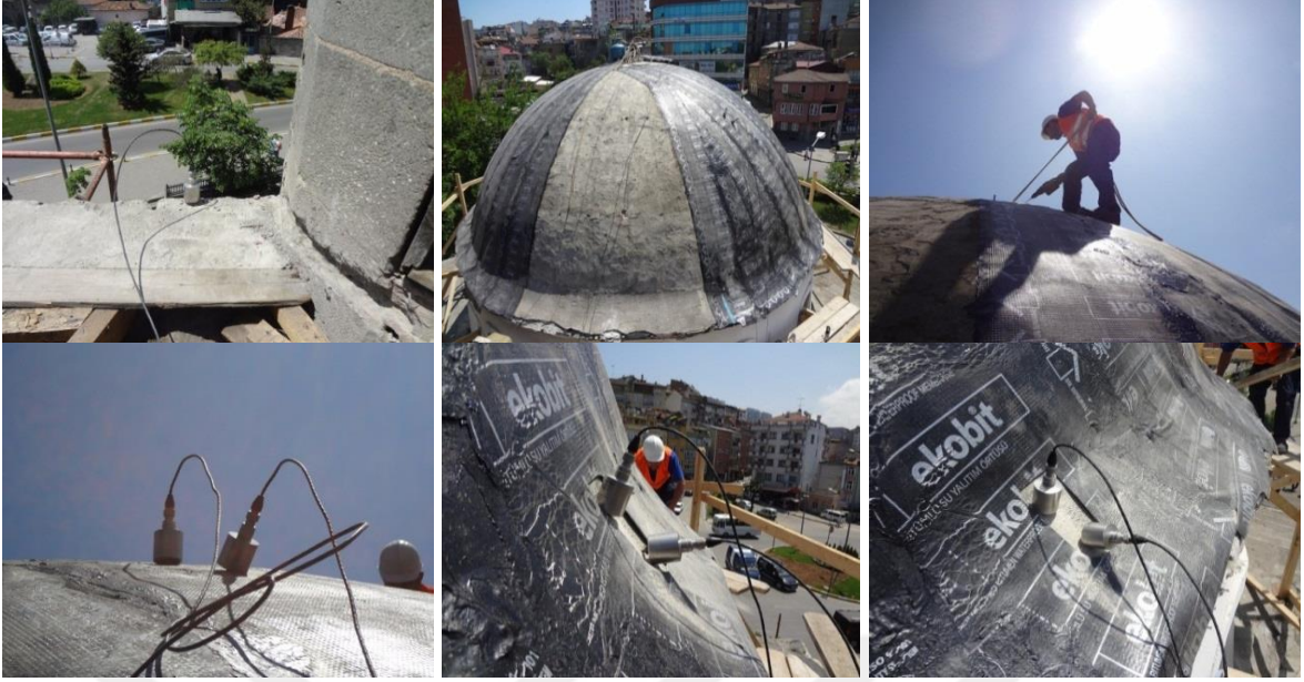
Şekil 2.217. Hacı Kasım Camisi restorasyon öncesi ölçüm görüntüleri
