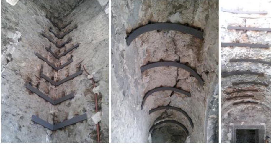
Şekil 2.235.Molla Siyah Camii duvar ve tonoz güçlendirme imalatları
