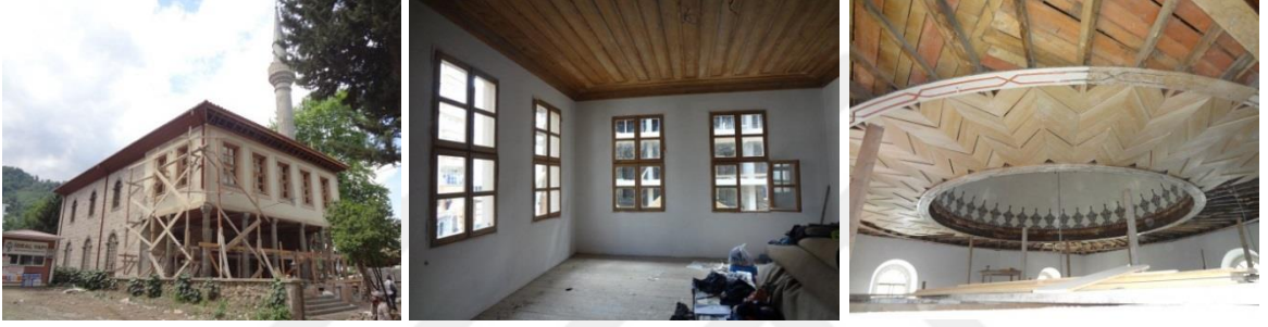
Şekil 2.6. Büyük Gülbahar Camii restorasyonu cephe ve tavan işleri
