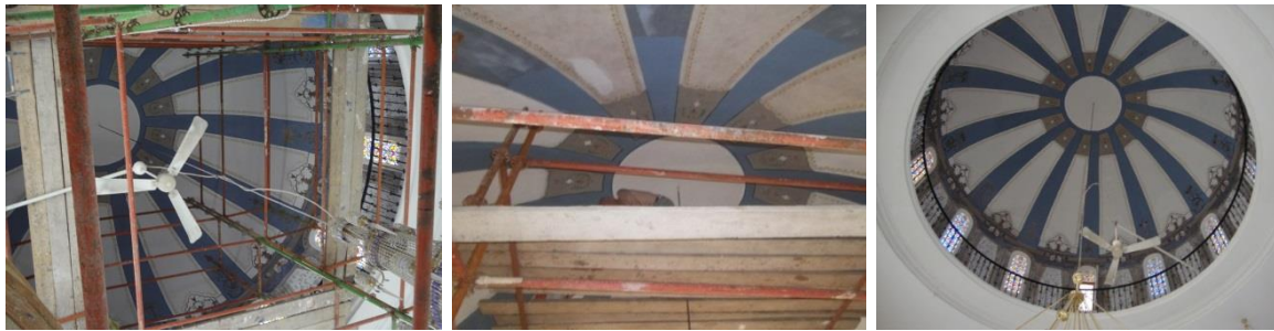
Şekil 2.213. Hacı Kasım Camii kubbe altındaki süsleme imalatı
