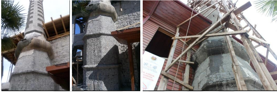
Şekil 2.73. Hacıbaşı Camii minare imalatları
