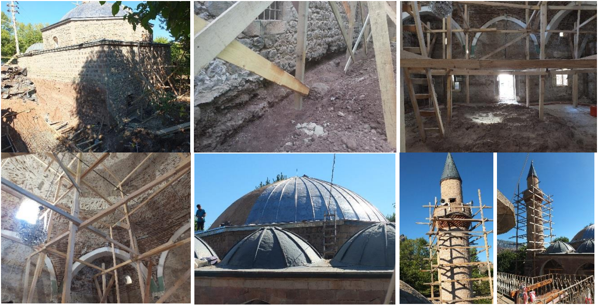
Şekil 2.251. Behramşah Camii restorasyonuna ait görüntüler
