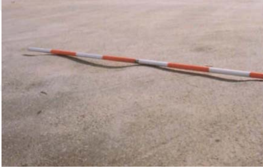
Şekil 21. Kaplamada ondülasyon oluşumu [175].
