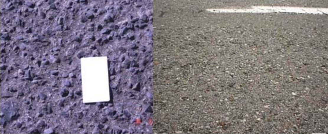
Şekil 23. Kaplamada sökölme oluşumu [175].
