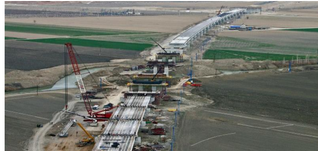
Şekil 1.3. I enkesitli kirişlerle inşa edilen prefabrike öngerilmeli beton bir köprü görünümü (Caner vd., 2007).
