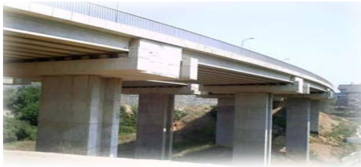
Şekil 1.9. Öngerilmeli kirişlerle inşa edilmiş bir köprü üstyapısı örneği (Akoğul, 2007).
