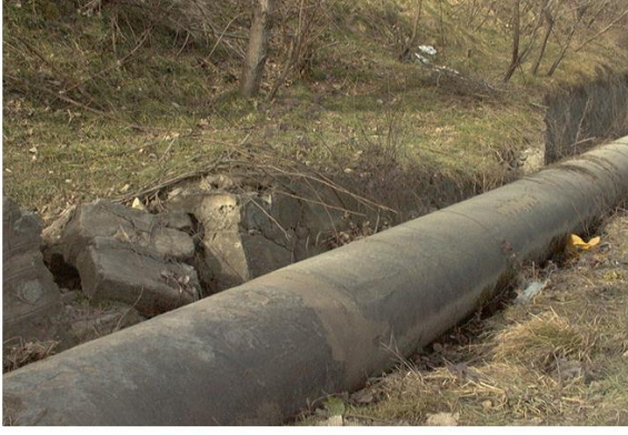
a) İçme suyu isale hattı ve istinat duvarı
