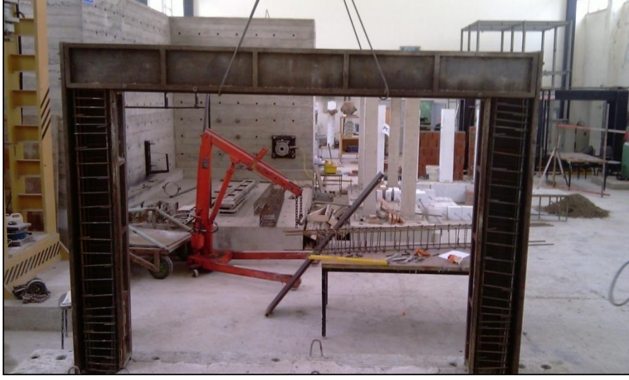
Şekil 2.6. Deney çerçeve donatılarının kalıplara yerleştirilmelerinden bir görünüm
