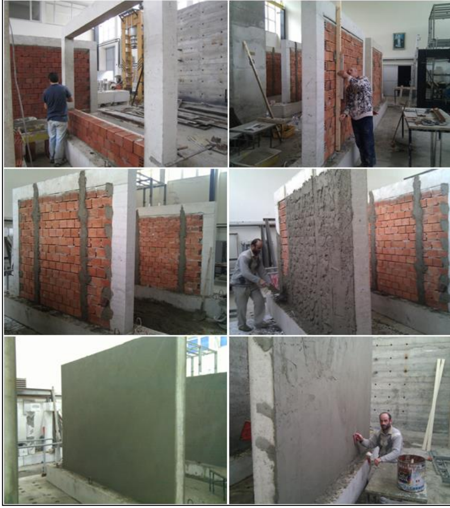
Şekil 2.10. Çerçeve dolgu duvarlarının örülmesi ve sıvanmasına ilişkin görüntüler
