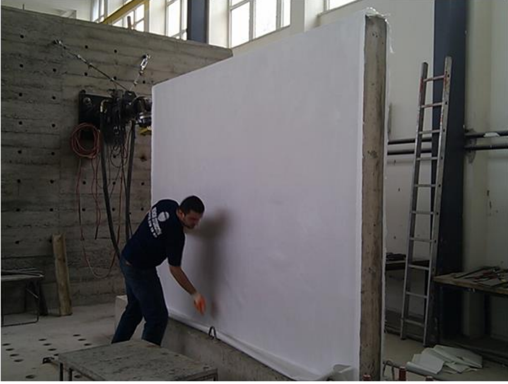
Şekil 1.18. Deprem kumaşının betonarme bir çerçevenin dolgu duvarına uygulanışı
