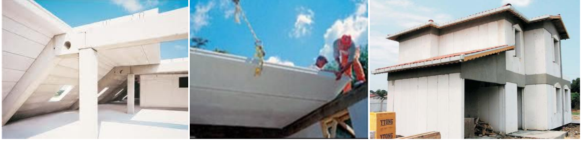
Şekil 19. Hafif beton bloklarla yapılan yapılar
