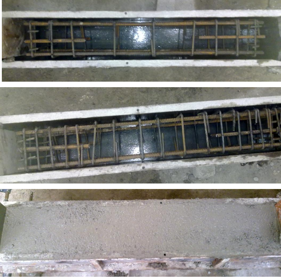
Şekil 56. Deney kolonlarının donatılarının kalıplarına yerleştirilmesi ve beton dökümü
