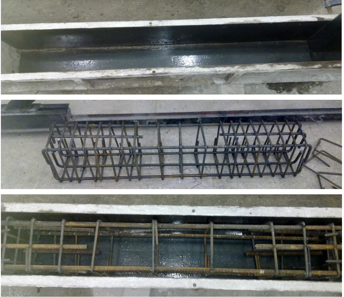
Şekil 46. Betonarme kiriş kalıp ve donatısı
