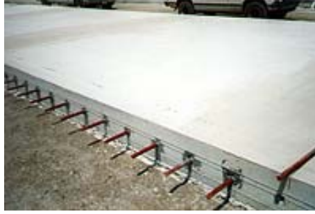
Şekil 1.37. Beton yolda bağlantı demirleri
