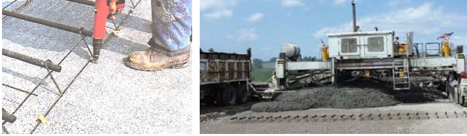
Şekil 1.12. Kayma demiri montajı Şekil 1.13. Kayma demirleri üzerine beton dökümü
