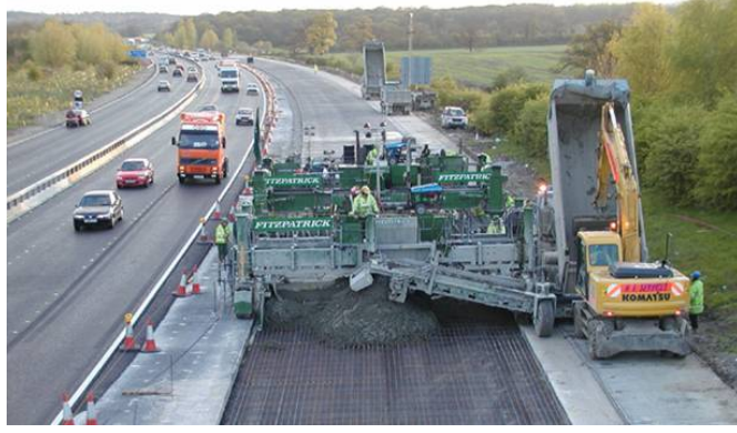
Şekil 1.9. Beton dökümü
