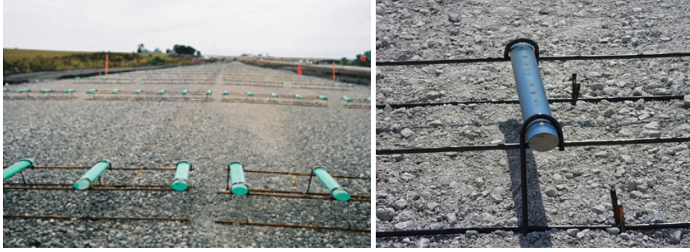
Şekil 1.31. Eliptik şeklinde kayma demirleri
