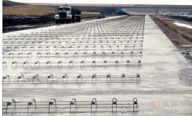
Şekil 1.28. Kayma demir uygulaması
