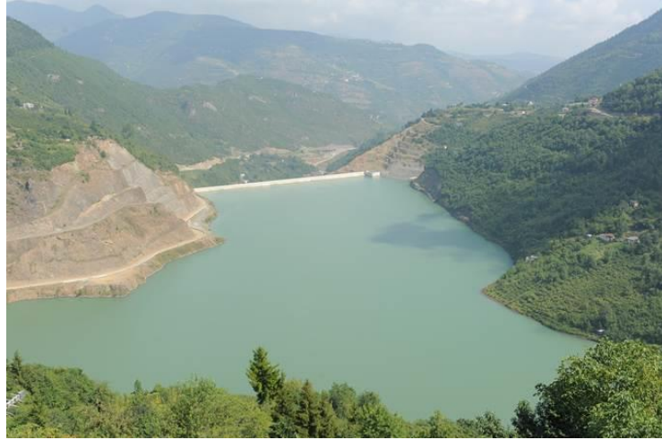
Şekil 1.4. Atasu Barajından genel görünüş (URL-2, 2014)
