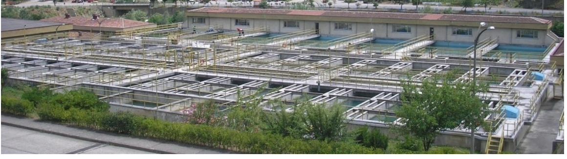
Şekil 1.3. Trabzon içme suyu arıtma tesisi
