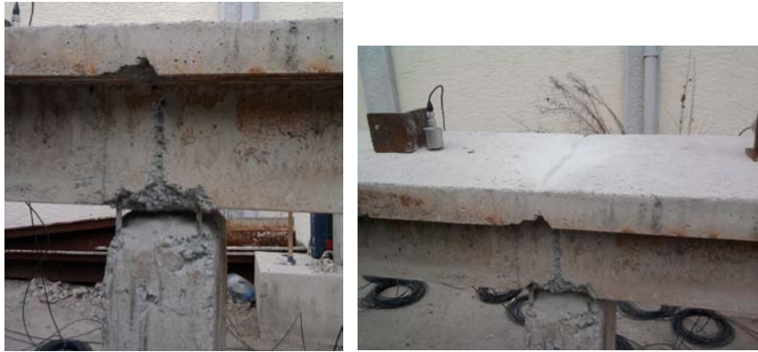
Şekil 2.101. Köprü modelde tabliye hasarı durumu
