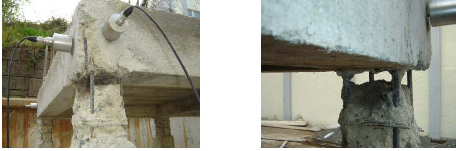
Şekil 2.45. Tek katlı betonarme modelde A-1 kolonu üst ucu göbek betonu hasarı
