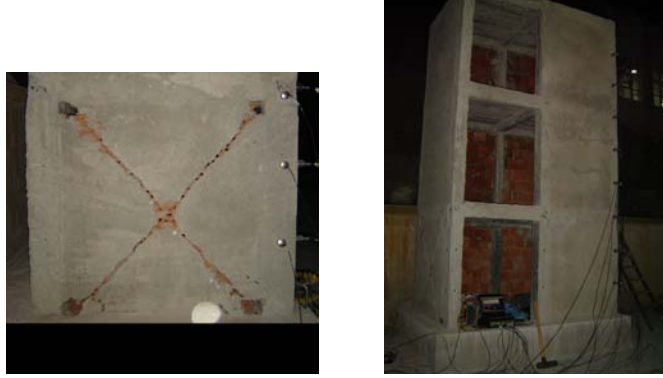
Şekil 2.70. Üç katlı betonarme bina modelde Hasar 1 durumu
