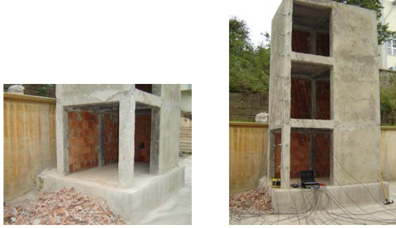
Şekil 2.73. Üç katlı betonarme bina modelde Hasar 2 durumu
