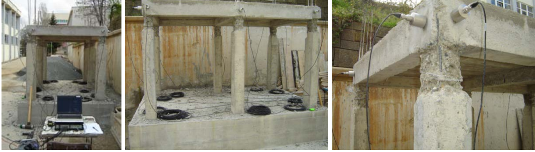
Şekil 2.39. Tek katlı betonarme modelde kolon üst uçları kabuk betonu hasarı
