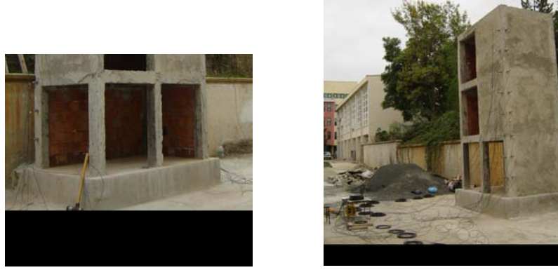
Şekil 2.76. Üç katlı betonarme bina modelde Hasar 3 durumu
