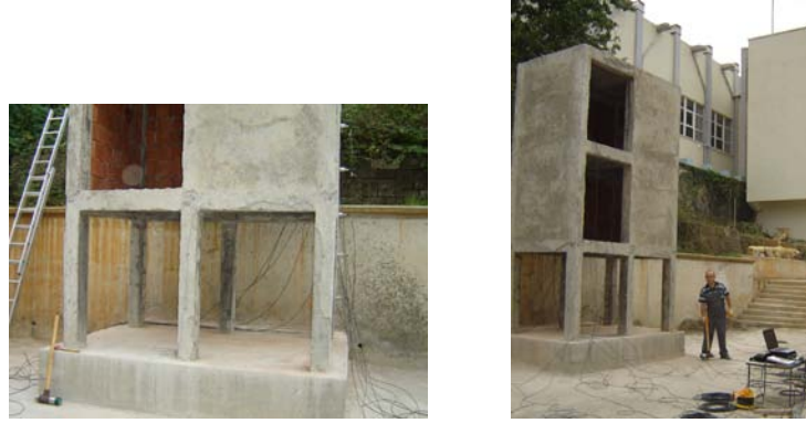
Şekil 2.79. Üç katlı betonarme bina modelde Hasar 4 durumu
