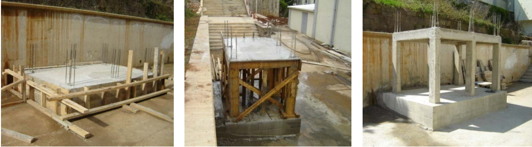
Şekil 2.28 Tek katlı betonarme modelin inşa aşamalarına ait görüntüler
