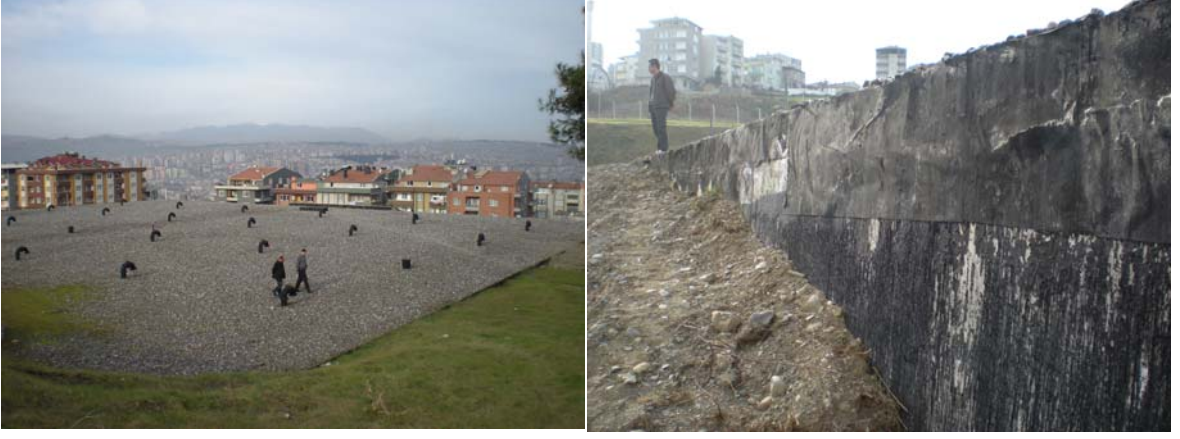
Şekil 23. Samsun ili Canik ilçesi 15000 m 3 hacmindeki dikdörtgen depoya ait görünüşler
