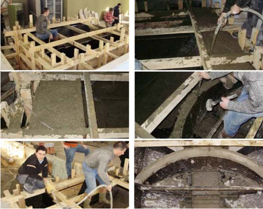
Şekil 17. Beton dökümüne ait bazı fotoğraflar
