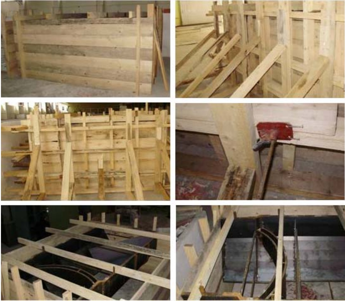
Şekil 16. Ahşap kalıbın yapımına ait bazı fotoğraflar
