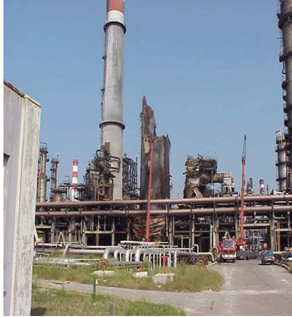
Şekil 3.121. 17 Ağustos 1999 Kocaeli depreminde yıkılan sanayi bacasına ait fotoğraflar (Huang ve Gould, 2007 )
