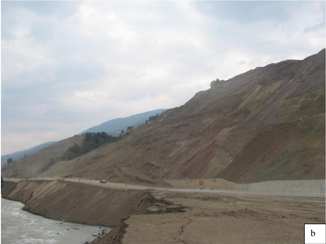
Şekil 27. Niksar-Reşadiye karayolu 33. km' de heyelan a.heyelan öncesi b.heyelan sonrası
