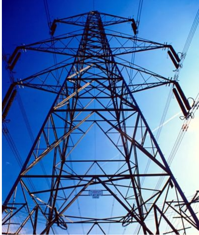
Şekil 1.2. Tipik bir elektrik iletim hattı kulesi
