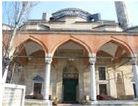
Şekil 2.282. Silivrikapı Hadım İbrahim Paşa camisi (URL-1, 2010)
