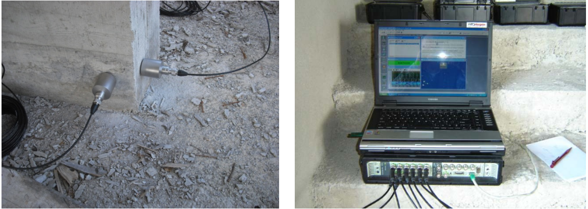
Şekil 2.30. Betonarme binadan ölçüm alınması
