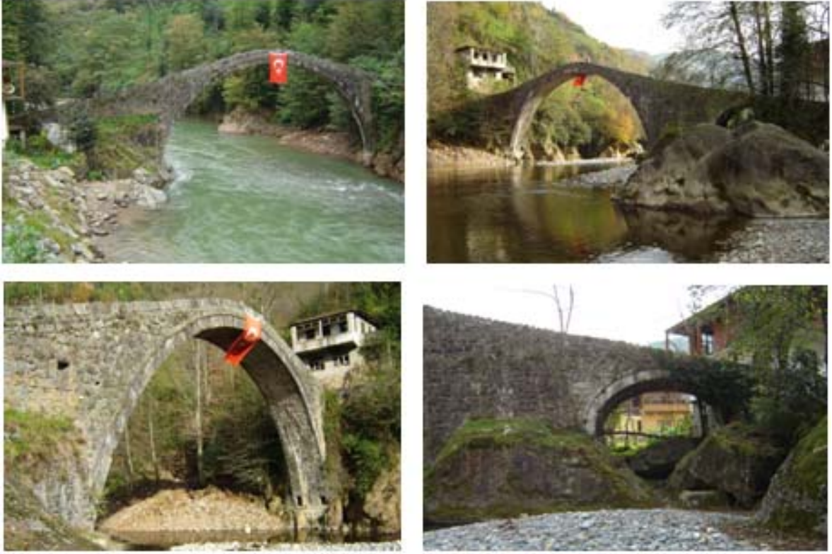
Şekil 2.53. Osmanlı yığma taş kemer köprüsüne ait bazı görüşler
