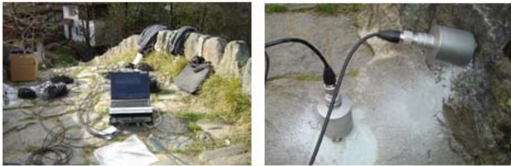
Şekil 2.54. Yığma köprüde deneysel ölçümlerde kullanılan veri toplama ünitesi ve tek eksenli ivmeölçerler
