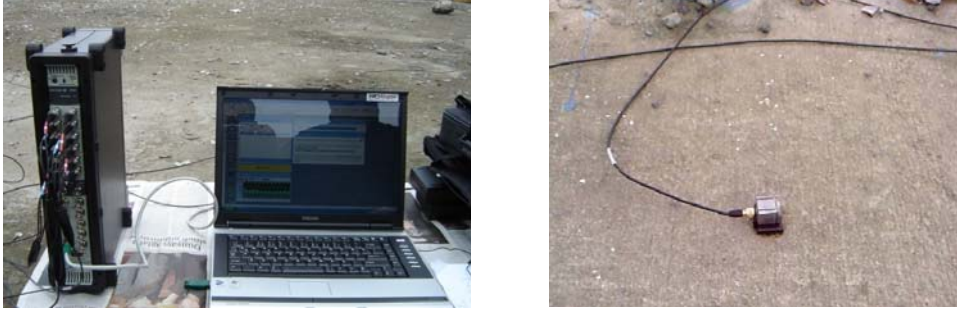
Şekil 2.46. Betonarme köprüde deneysel ölçümlerde kullanılan veri toplama ünitesi ve üç eksenli ivmeölçer
