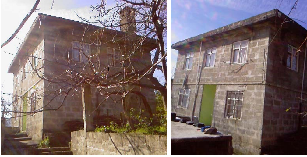
Şekil 2.37. Ölçüm alınan yığma bina
