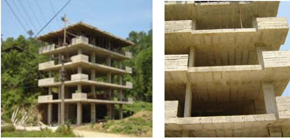
Şekil 2.29. Ölçüm alınan betonarme bina
