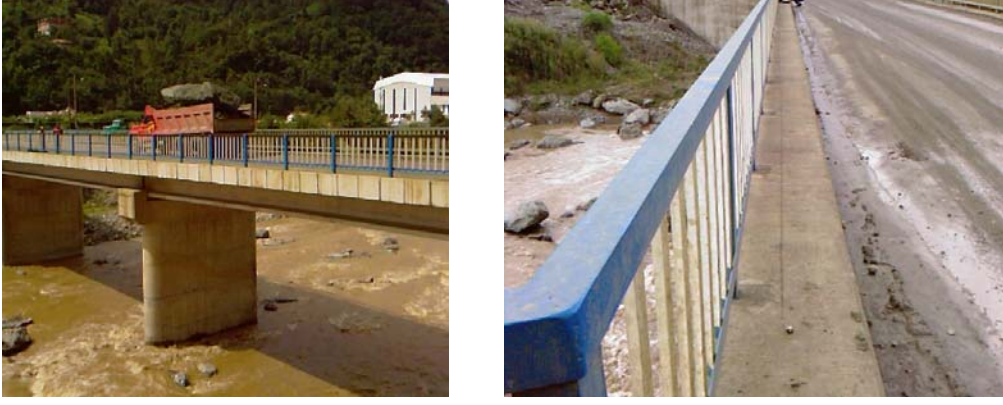
Şekil 2.45. Betonarme karayolu köprüsüne ait bazı görüşler
