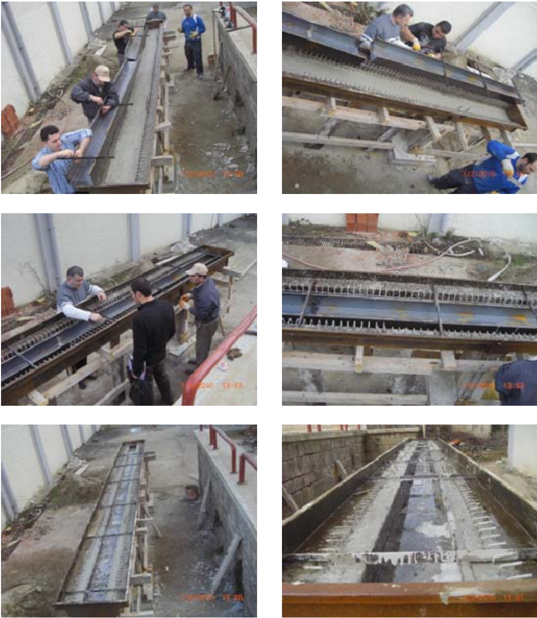
Şekil 2.7. Kutu kesit alt tabla ve yan cidarlarının beton dökümüne ait bazı fotoğraflar
