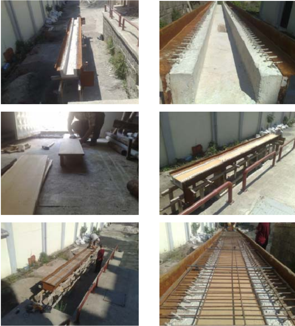
Şekil 2.8. İç kalıbın alınması, geçici sunta kalıbın yapılması ve donatılar ile birlikte yerleştirilmesine ait bazı fotoğraflar
