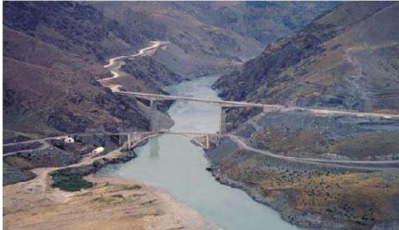
Şekil 2.31. Kömürhan Köprüsü'ne ait bazı fotoğraflar
