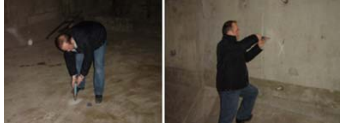
Şekil 2.55. Schmidt çekici ile yapılan ölçümlere ait bazı görüntüler
