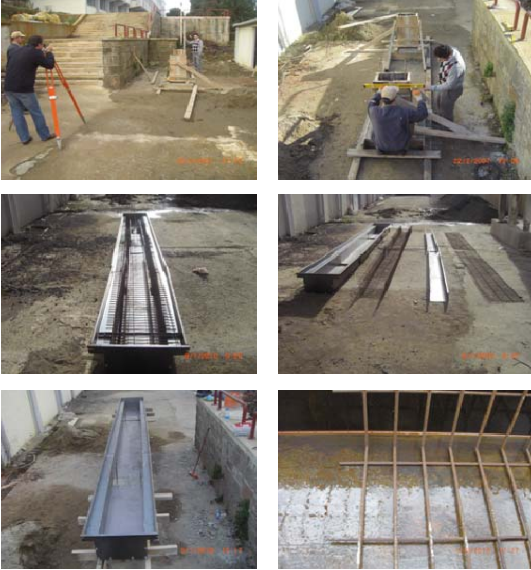
Şekil 2.6. Dış kalıp ile hasır donatının yerleştirilmesine ait bazı fotoğraflar
