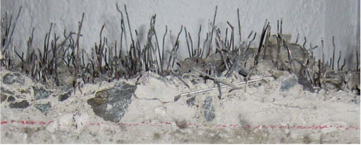
Şekil 1.31. Yarma deneyine tabi bir lifli silindir betondan görünüm
