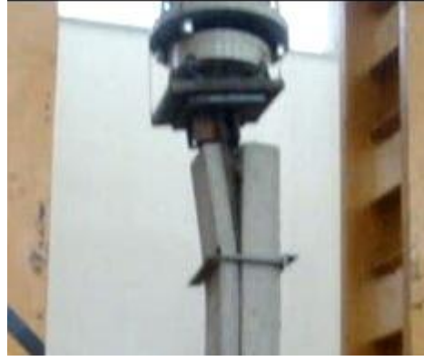
Şekil 3.15. Bağlantı korniyerinin, çaprazın burkulmasından sonra, ayrılması
