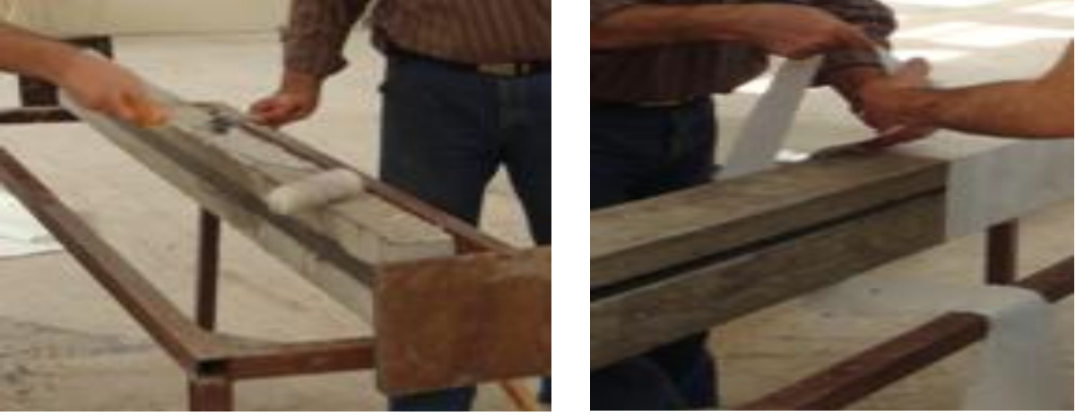
Şekil 2.29. Lirefa malzemesi ile prefabrike elemanların sarılması
