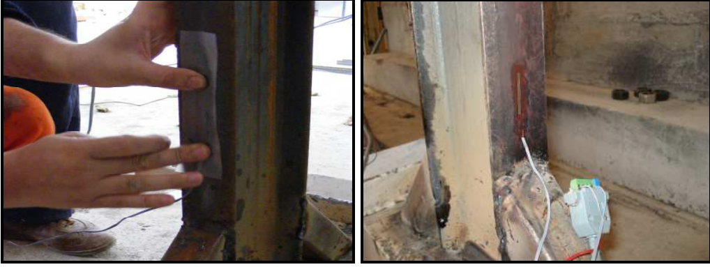
Şekil 44. Şekildeğiştirme ölçerlerinin (STR:Strain Gauges) yerleştirilmesi
