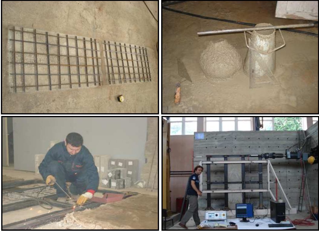
Şekil 52. Betonarme dolgu duvarının hazırlanma aşamaları
