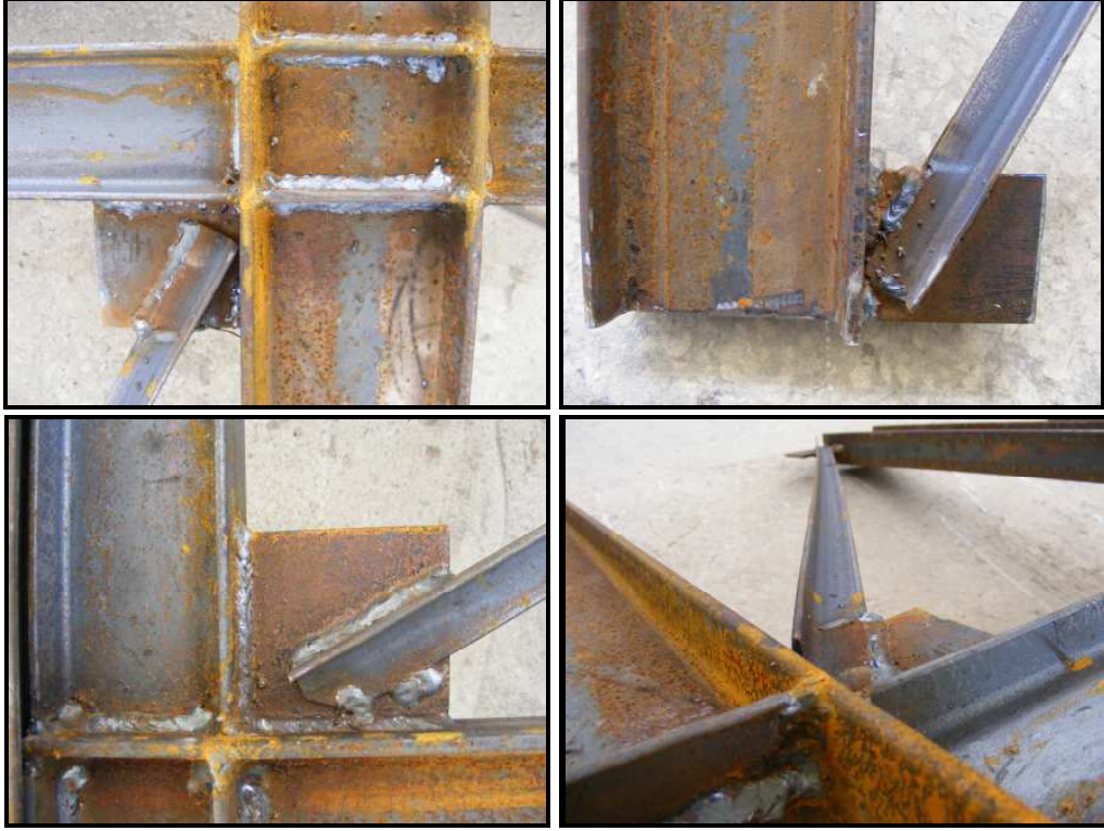
Şekil 59. Çelik köşegenlerin birleşim detayları
