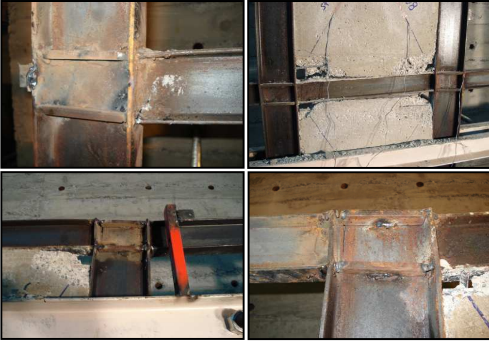
Şekil 96. Betonarme dolgu duvarlı çelik çerçeve numunesinin deney sonrası birleşim noktalarında oluşan hasarlar
