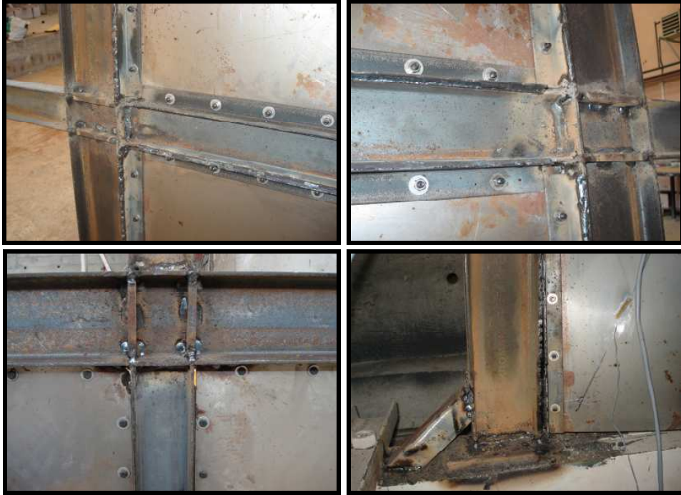
Şekil 55. Çelik levhaların çerçeveye bağlantısı
