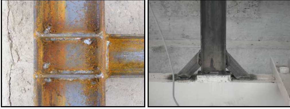
Şekil 73. Kolon kiriş birleşimlerinde ve kolon ayaklarında yapılan güçlendirmeler
