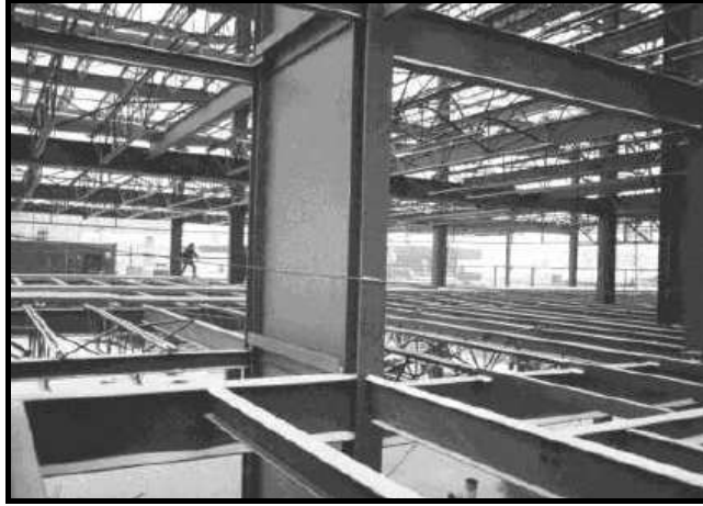
Şekil 9. Kanada'da 6 katlı çelik levha perdeli bina
