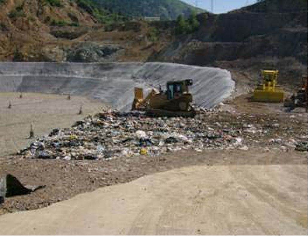
Şekil 1.8. Çöplerin katı atık imha alanına serilmesi ve sıkıştırılması (URL-3, 2008).
