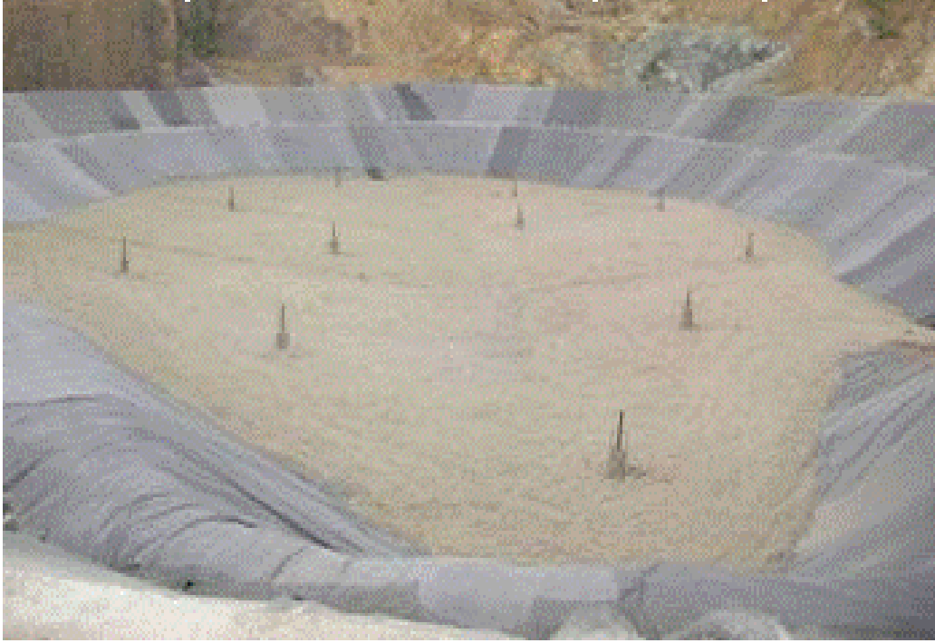
Şekil 1.7. Drenaj borularının üzerine çakıl tabakası serilmesi ve gaz bacalarının oluşturulması (URL-3, 2008).
