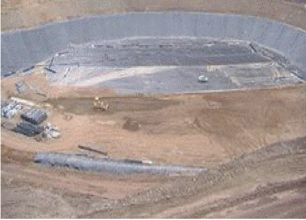
Şekil 1.4. İlk kademe yalıtım için kil-bentonit karışımının serilmesi (URL-3, 2008).
