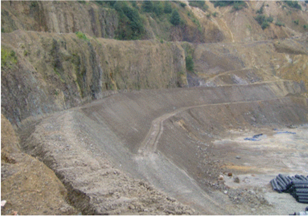
Şekil 1.3. Oluşturulan şevlerle sahanın kademelendirilmesi (URL-3, 2008).
