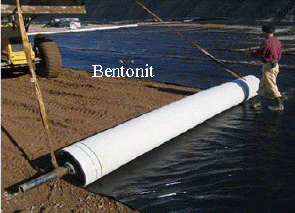
Şekil 1.5. Kil-bentonit karışımı üzerine yüksek yoğunluklu polietilen malzeme (geomembran) serilmesi (URL-3, 2008).
