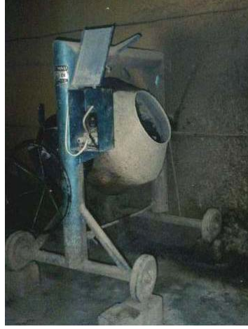
Şekil 33. Betonların karılmasında kullanılan betoniyer
