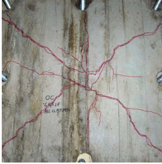
Şekil 129. AGL4 döşemesine ait göçme mekanizması
