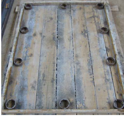
Şekil 39. Döşeme kalıbı ve ankraj boşluklarının önceden bırakılması
