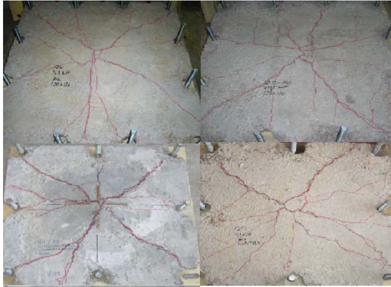
Şekil 168. Bazı lifli döşemelerin deneysel göçme mekanizmaları
