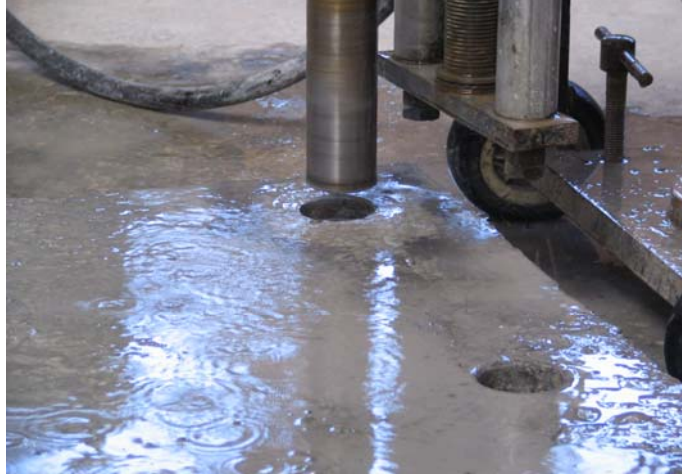
Şekil 40. Döşemelerde karot alınarak delik açılması
