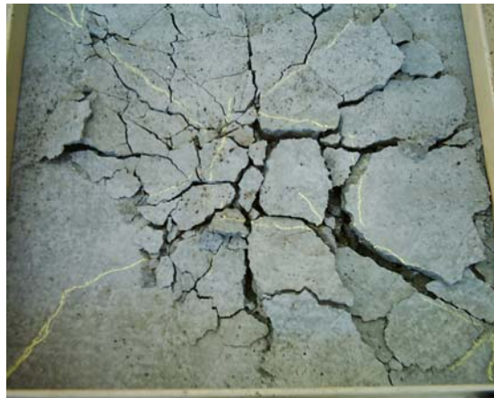
Şekil 69. A8 döşemesine ait plastik mafsallık çizgileri
