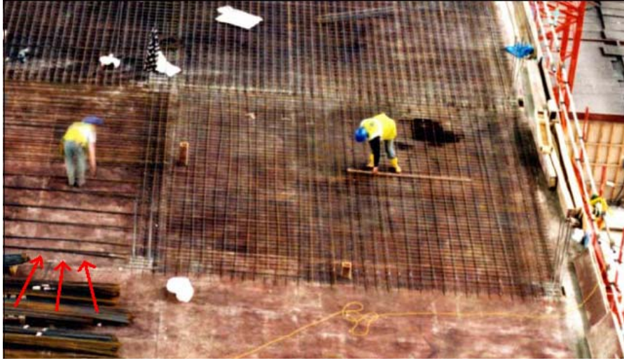
Şekil 31. Elastik analiz ve plastik mafsal izgileri yöntemi ile boyutlandırılan döşemeler [50].
