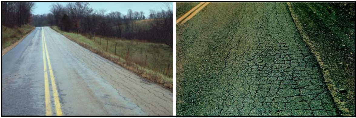
Şekil 20. Yorulma çatlamlarına örnekler [46].
