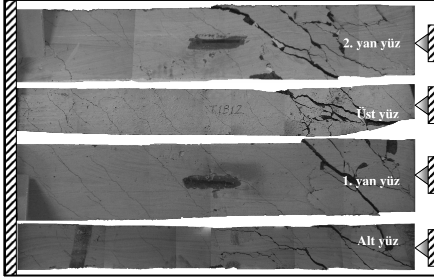
Şekil 86. T1B12 kirişinin deney sonrası çatlakları
